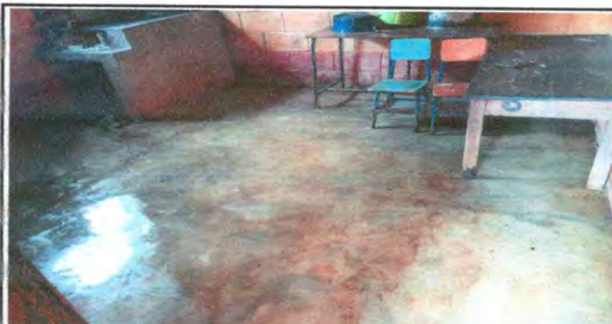
Foto 16: Sustitución de piso de torta de concreto por granito en cocina
