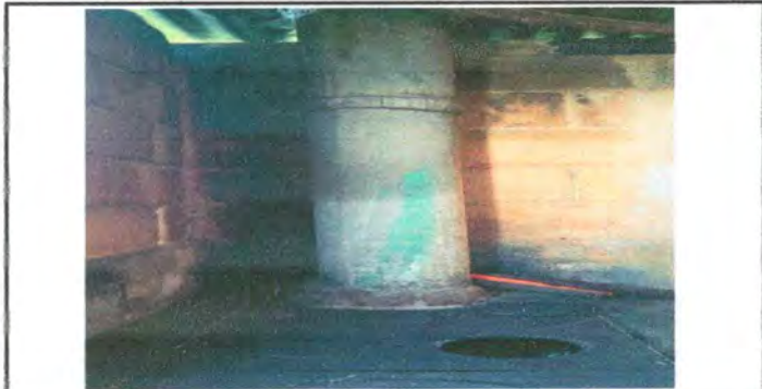
Foto 5: Sustitución de chimenea
