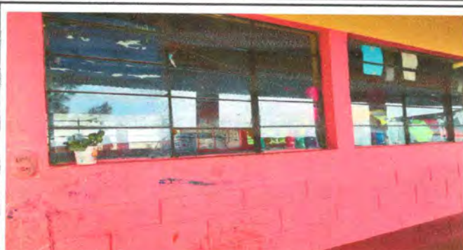
Foto 14: pintura en exteriores de aulas
