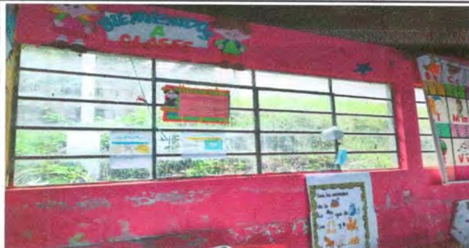
Foto 13: pintura en interiores de aulas
