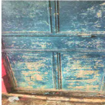
Foto 8: Mantenimiento de puerta de cocina y cambio de chapa
