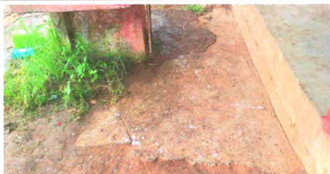
Foto 7: Reparación de losa de concreto de patio
