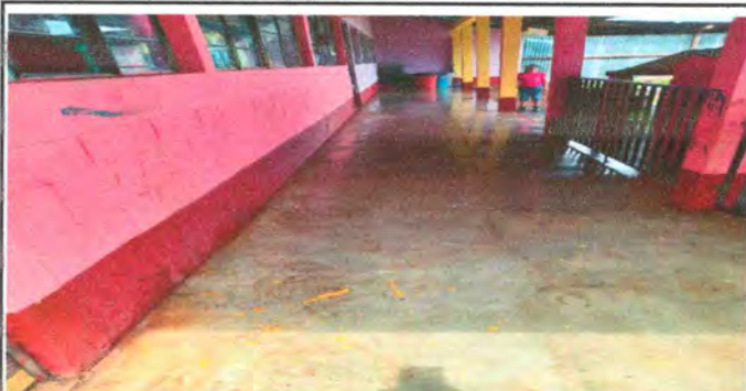
Foto 15: Sustitución de piso de torta de concreto por granito en corredor
