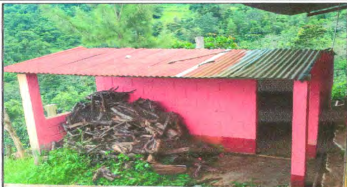
Foto1: sustitución de lámina troquelada
