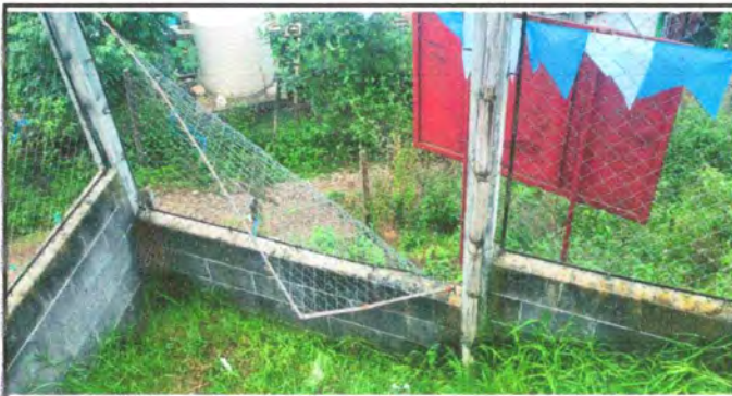
Foto 10: Reparación de muro perimetral
