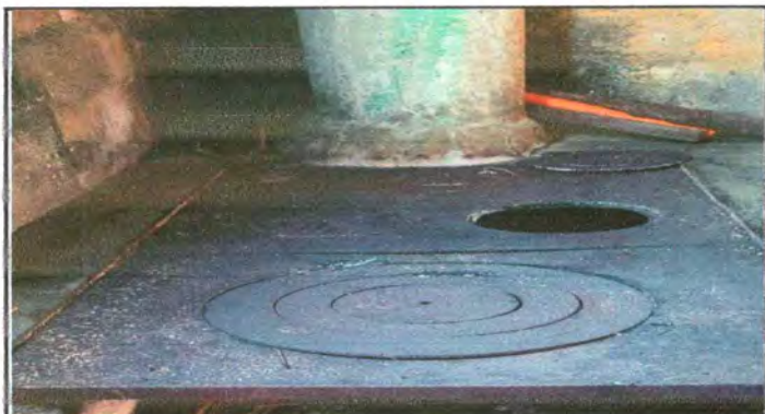
Foto 3: Sustitución de plancha
