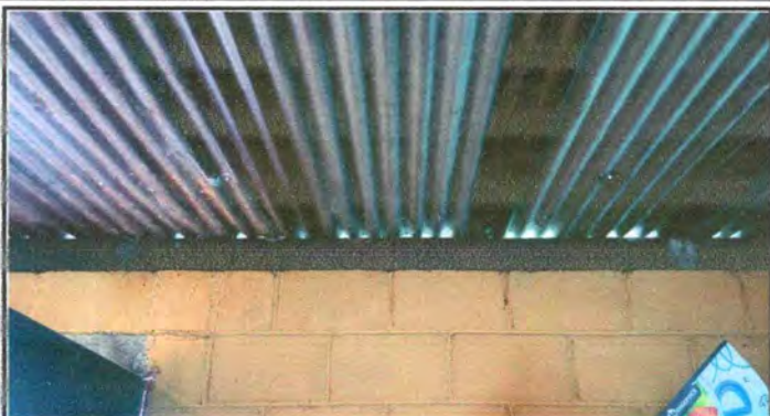
Foto 2: sustitución de estructura madera por metal
