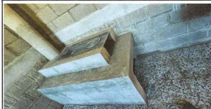
Foto 6: Mejoramiento de estufa rural (completa) block, cemento, incluye chimenea con tubos de cemento y plancha de metal
