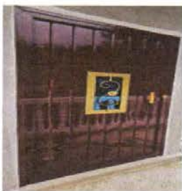
Foto 3: Mejoramiento puerta de la cocina
