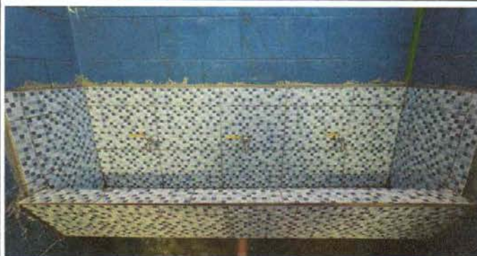
Foto 7.1: Sustrución de azulejo por azulejo
