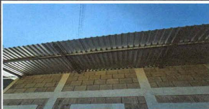
Foto 5: Mejoramiento de paredes de la cocina
