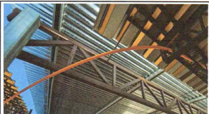
Foto 10.4: Reparación de cableado eléctrico
