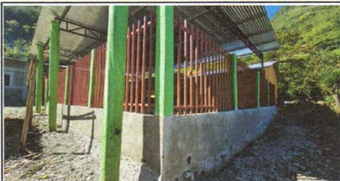
Foto 9: Mejoramiento de muro perimetral repello
