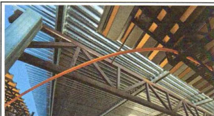
Foto 10.5: Reparación de ducto eléctrico
