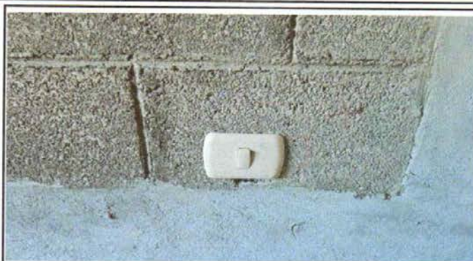
Foto 10.3: Mejoramiento de apagadores
