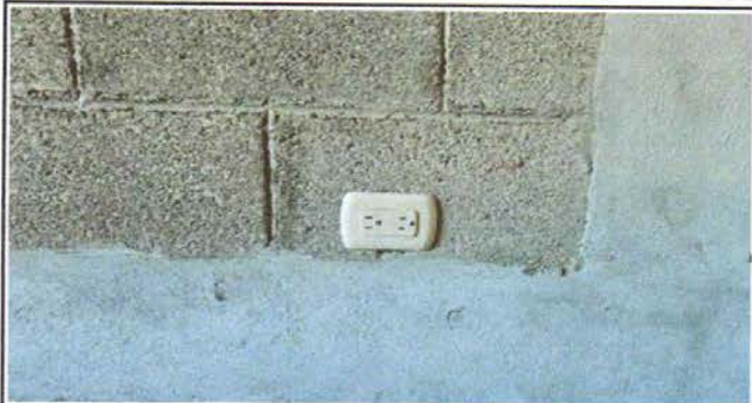
Foto 10.2 : Mejoramiento de toma corrientes
