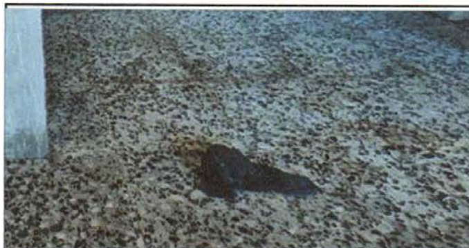
Foto 4: Mejoramiento del piso de granito de la cocina (Cemento)
