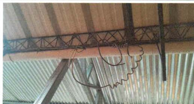
Foto 10.5: Reparación de ducto eléctrico
