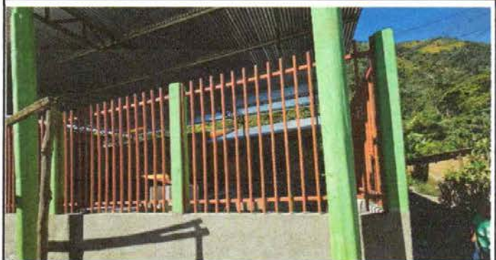
Foto 9: Mejoramiento de muro perimetral repello
