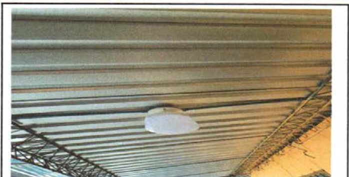
Foto 10.1: Sustitución de plafoneras por plafoneras
