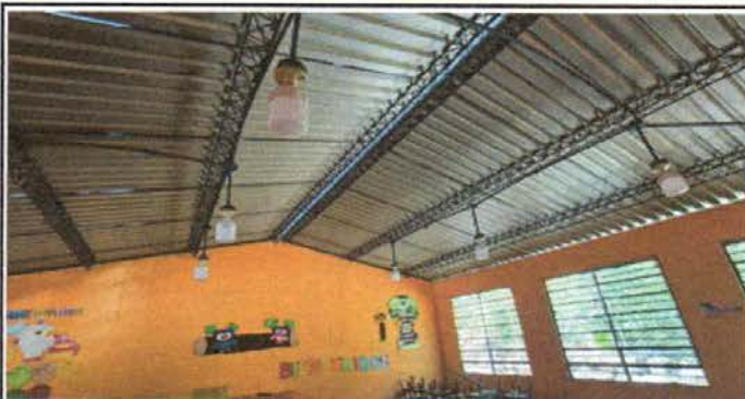
Foto 10: Mejoramiento de lamparas led
