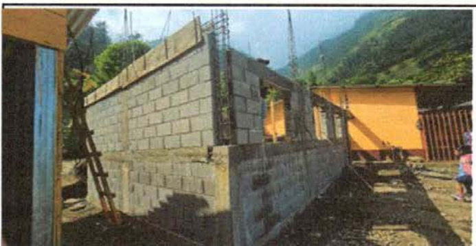
Foto 5: Mejoramiento de paredes de la cocina
