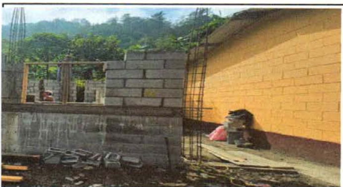
Foto 3: Mejoramiento puerta de la cocina
