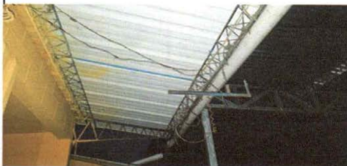
Foto 10.4: Reparación de cableado eléctrico
