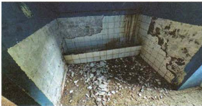
Foto 7: Sustitución de accesorios en migitorio y lava manos
