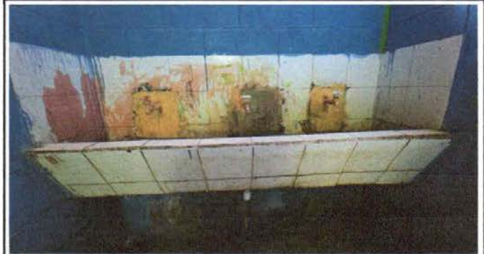
Foto 7.1: Sustitución de azulejo por azulejo
