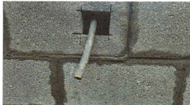
Foto 10.3: Mejoramiento de apagadores
