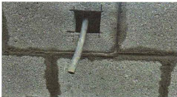
Foto 10.2 : Mejoramiento de toma corrientes
