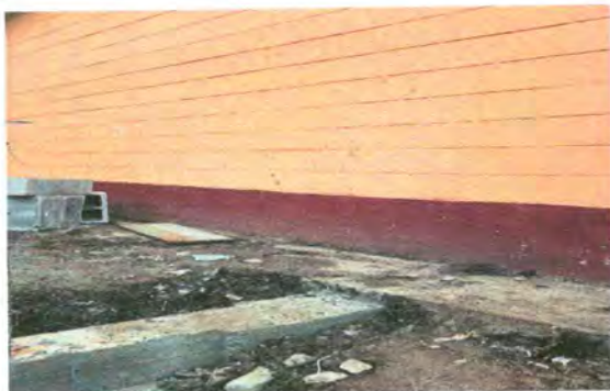
Foto 3: Mejoramiento puerta de la cocina
