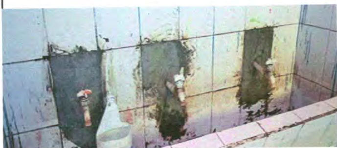
Foto7: Sustitución de accesorios en migitorio y lava manos
