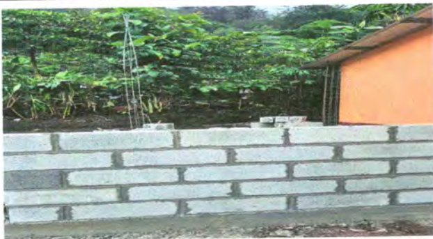
Foto 5: Mejoramiento de paredes de la cocina
