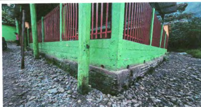
Foto 9: Mejoramiento de muro perimetral repello
