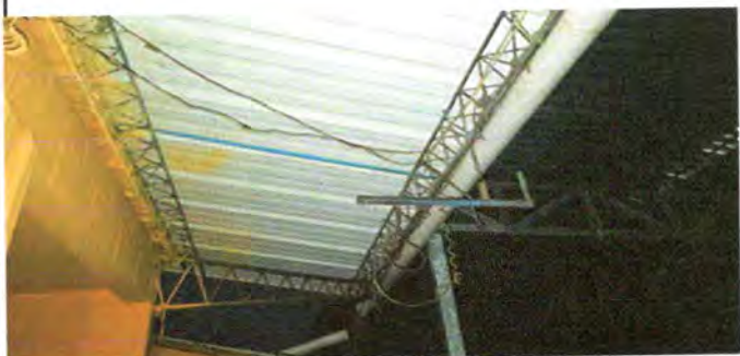
Foto 10.4: Reparación de cableado eléctrico
