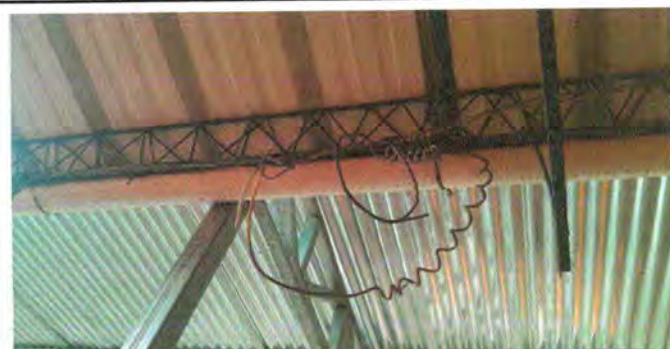
Foto 10.5: Reparación de ducto eléctrico
