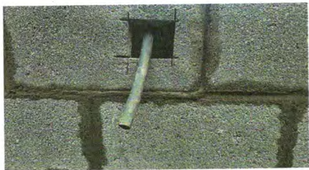
Foto 10.2 : Mejoramiento de toma corrientes
