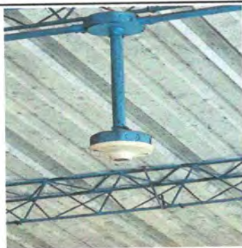
Foto 10: Mejoramiento de lamparas led
