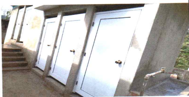
Foto 9: Finalización de repello en sanitarios
