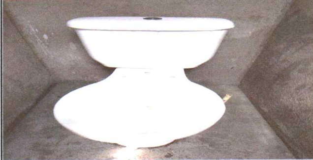
Foto 4: Finalización de sustitución de inodoro
