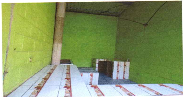
Foto7: Finalización de sustitución de chimenea de concreto
