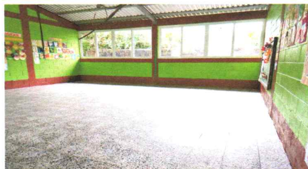
Foto 5: Finalización de sustitución de piso por piso granito
