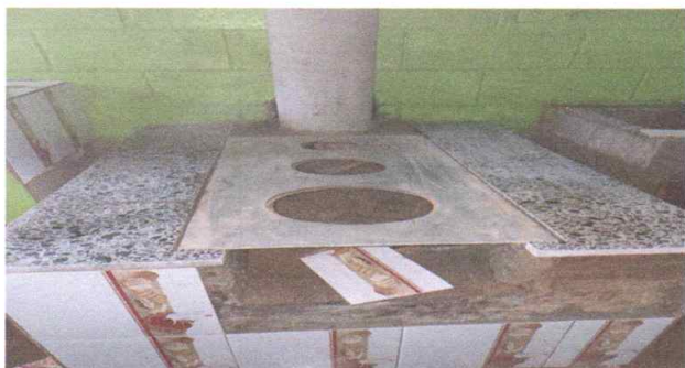
Foto 1: Finalización de colocación de plancha de metal
