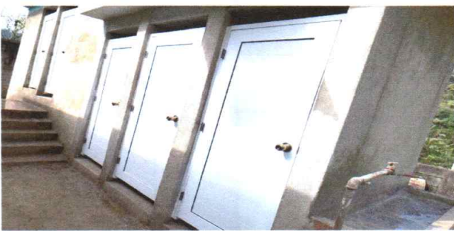
Foto 3: Finalización de sustitución de puertas en sanitarios
