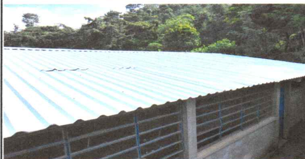
Foto 2: Finalización de sustitución de lámina
