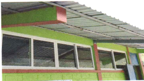
Foto 8: Finalización de sustitución de ventanas
