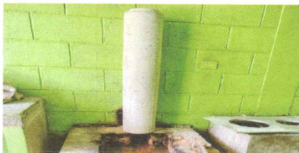
Foto 7: proceso de sustitución de chimenea de concreto
