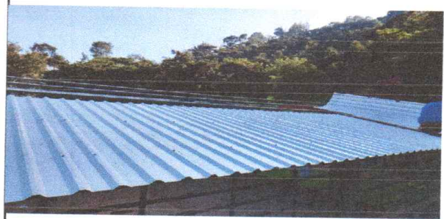
Foto 2: Proceso de sustitución de lámina
