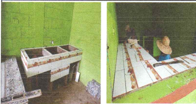
Foto 10: Proceso de remodelación a mesa y pila de cocina con azulejo
