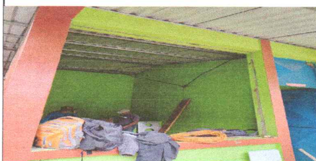
Foto 8: Proceso de sustitución de ventanas
