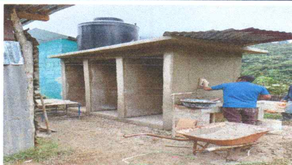
Foto 9: Proceso de repello de sanitarios
