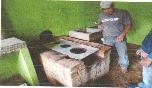
Foto1: En proceso colocación de plancha de metal
