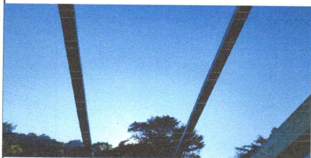
6. Proceso de sustitución de estructura de soporte de techo
