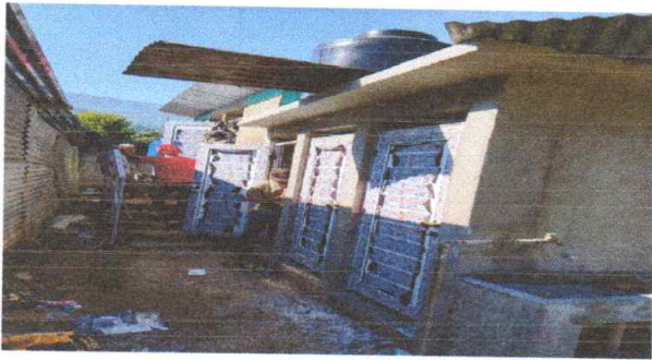
Foto 3: Porceso de sustitución de puertas en sanitarios
