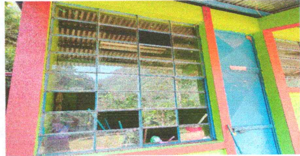
Foto 8: Sustitución de ventanas
