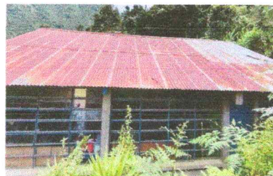
Foto 2: Sustitución de lámina
