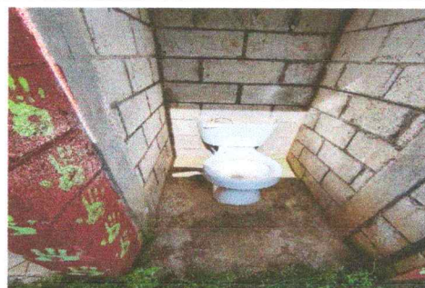
Foto 4: Sustitución de inodoros
