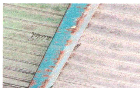
Foto 6: Sustitución de estructura de soporte de techo
