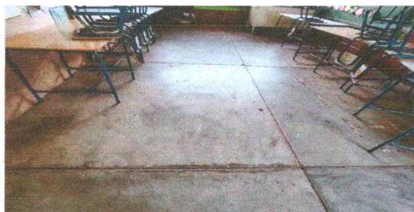
Foto 5: Sustitución de piso por piso granito
