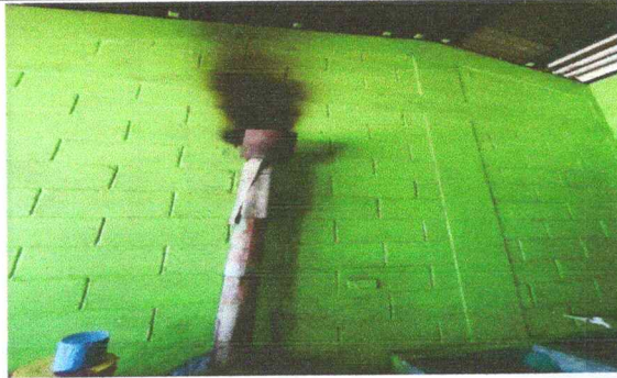
Foto 7: Sustitución de chimenea de concreto
