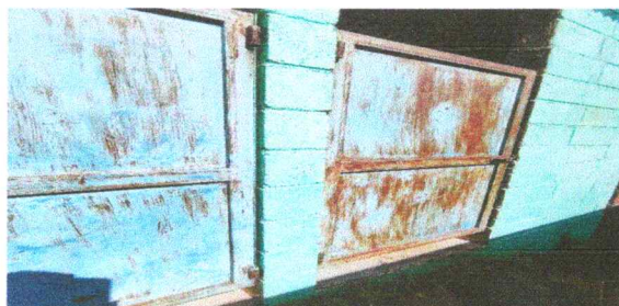
Foto 3: Sustitución de puertas en sanitarios
