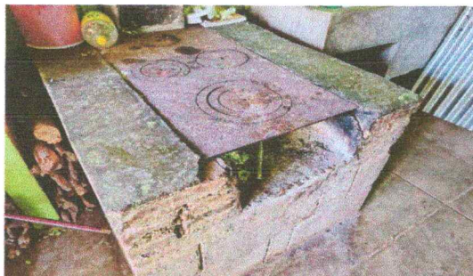
Foto 1: Sustitución de plancha de metal
