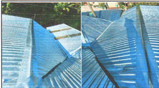
Foto 3: Sustitución de capote de lamina por capote de lámina Tecno Aluzinc
