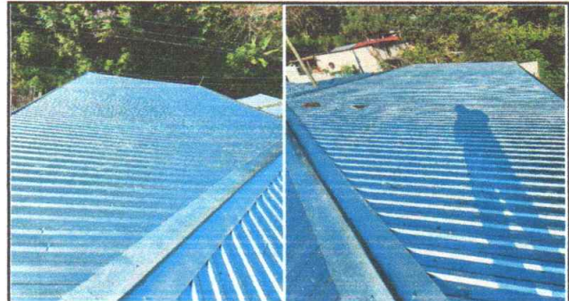
Foto 2: Sustitución de lámina por lámina Tecno Aluzinc calibre 26
