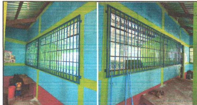
Foto 4: Sustitución de balcones
