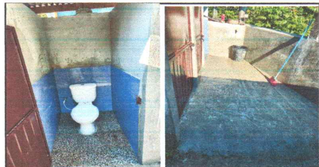
Foto 6: Reparación de servicios sanitarios
