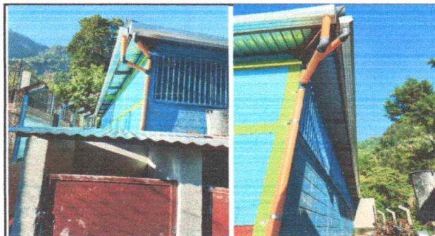
Foto 5: Sustitución de canal de metal
