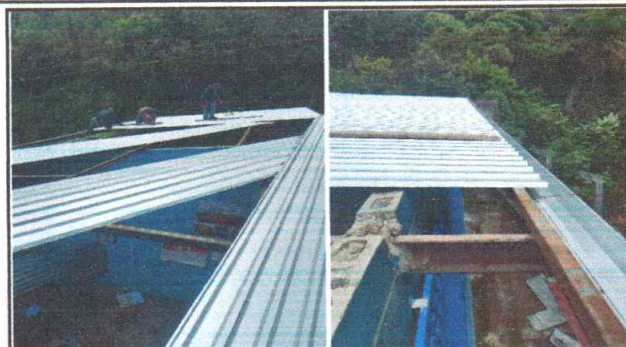
Foto 2: Sustitución de lámina por lámina Técn Aluzinc calibre 26
