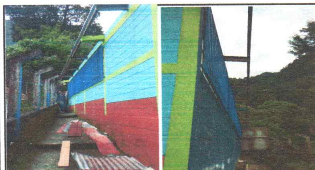
Foto 5: Sustitución de canal de metal
