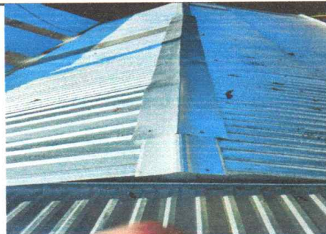
Foto 4: Sustitución de capote de lámina para lámina técn aluzinc
