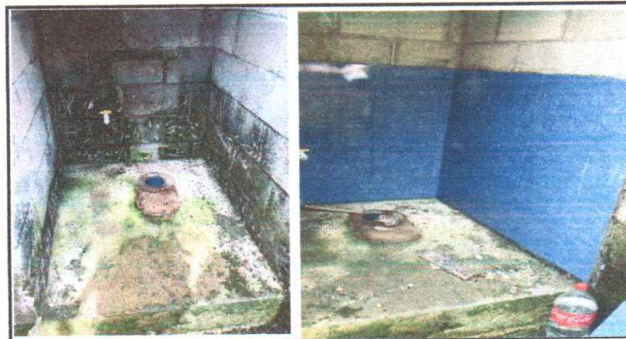
Foto 6: Reparación de servicios sanitarios
