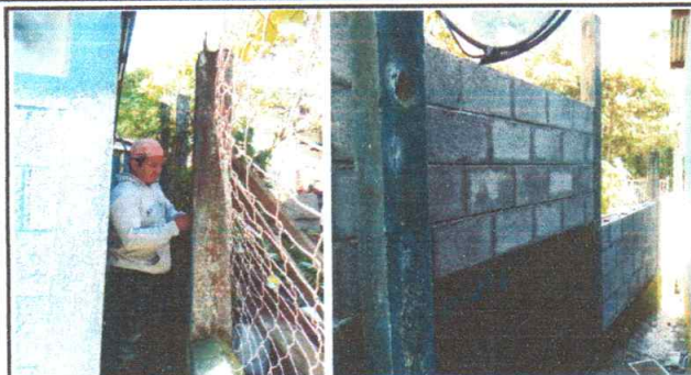
Foto 1: Reparación 18 m2 de muro perimetral de block
