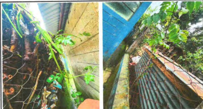
Foto1: Reparación 18 m2 de muro perimetral de block
