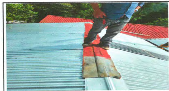
Foto 6: Sustitución de capote de lámina para lámina técnico aluzinc
