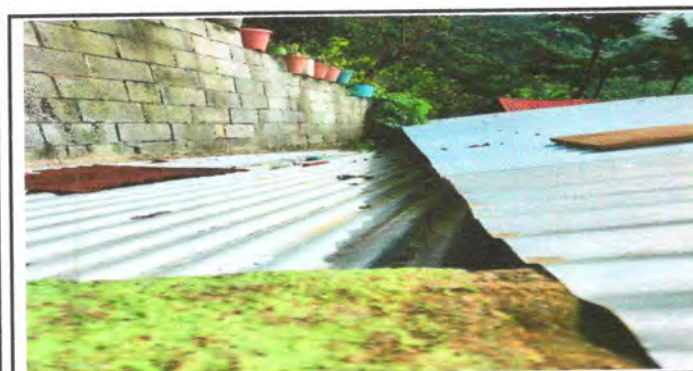
Foto 5: Sustitución de canal de metal
