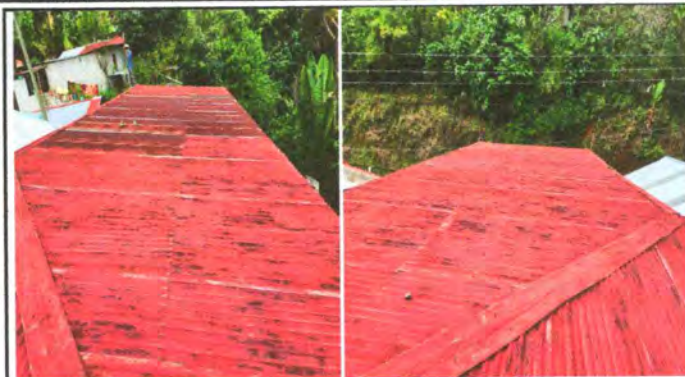
Foto 2: Sustitución de lámina por lámina Tecno Aluzinc calibre 26
