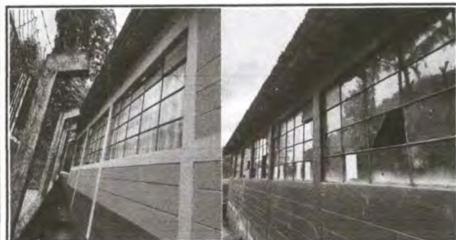
Foto 9: Sustitución de canal de metal
