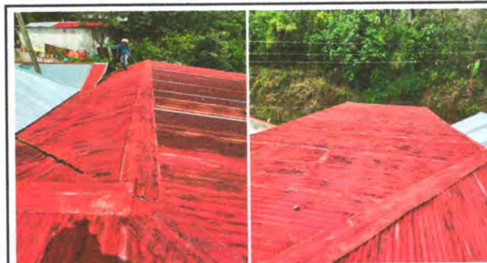
Foto 4: Sustitución de lámina por lámina Tecno aluzinc calibre 26
