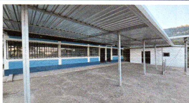
Foto 2: Cambio de madera por sustitución de metal terminado
