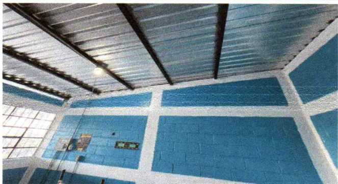
Foto1: Cambio de láminas de aulas terminado
