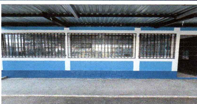
Foto 4: Sustitución balcones de metal terminado
