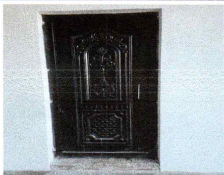
Foto 3: Sustitución de puerta terminado
