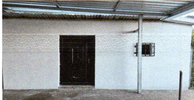
Foto 6: Repello y cernido de paredes terminado
