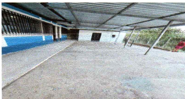
Foto 5: Plancha de concreto de patio terminado
