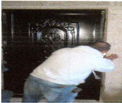
Foto 3: En proceso sustitución de puerta metálica
