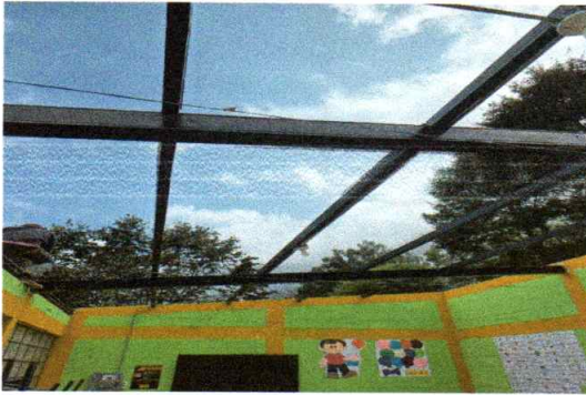
Foto1: En proceso de cambio de lámina
