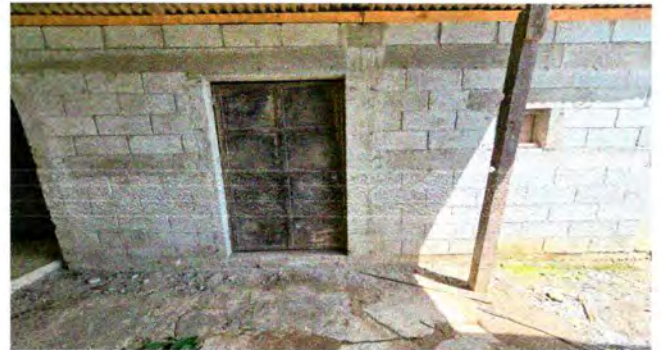
Foto 6: Reparación de repello y cernido de paredes
