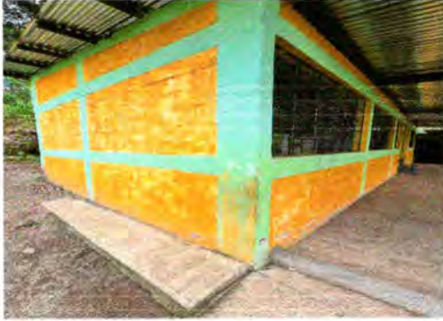
Foto 7: Pintura interior y exterior
