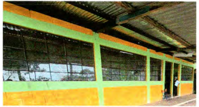
Foto 4: Sustitución balcones de metal
