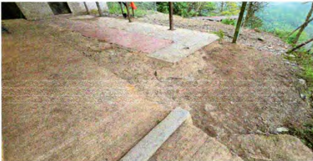
Foto 5: Reparación de plancha de concreto de patio
