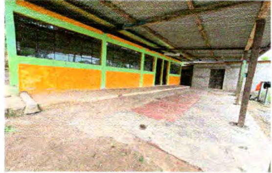
Foto 2: Sustitución de madera por costanera metálica
