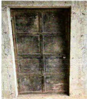
Foto 3: Sustitución de puerta metálica
