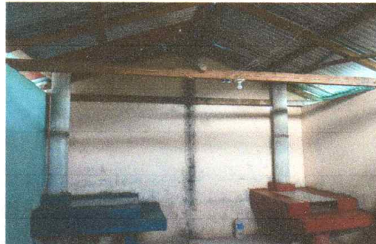
Foto 7: Sustrucción de plancha de metal de 3 hornillas y Sustrucción de chimenea de concreto.
