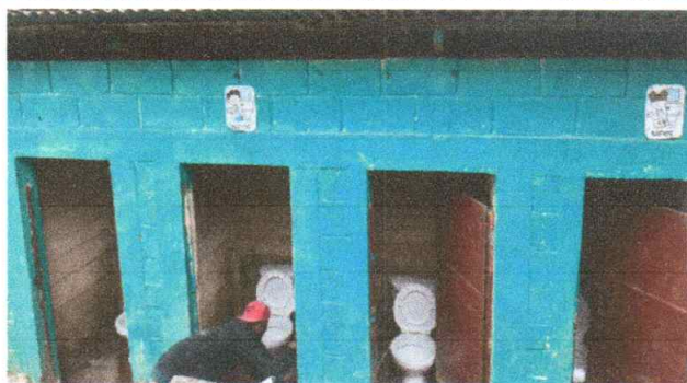
Foto 3: Cambio de inodoros
