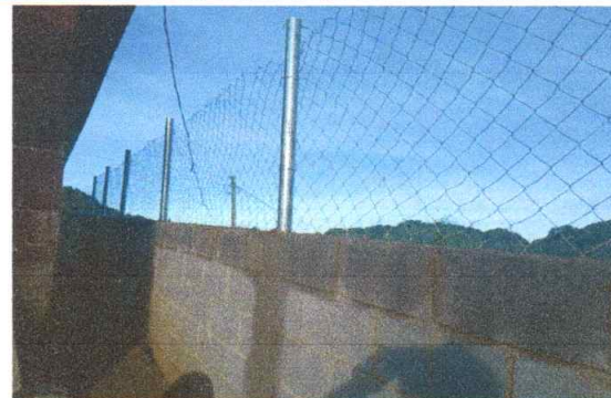
Foto 4: finalización de reparación de muro perimetral de block con tubo hg y malla galvanizada, soleras intermedias y columnas.
