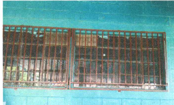
Foto 6: Sustrucción de vidrios
