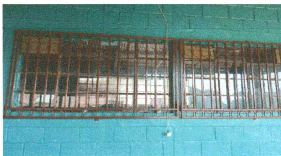
Foto 5: instalación de balcones de hierro en ventana
