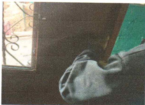
Foto 1: en proceso de sustitución de chapa
