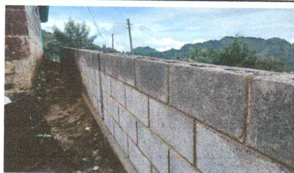
Foto 4: En proceso de reparación de muro perimetral de block con tubo hg y malla galvanizada, soleras intermedias y columnas.
