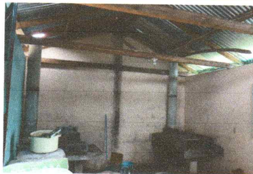
Foto 7: en proceso sustitución de plancha de metal de 3 hornillas y Sustitución de chimena de concreto.
