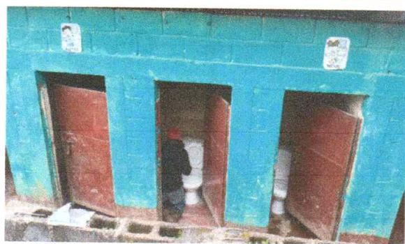
Foto 3: en proceso de sustitución de inodoros
