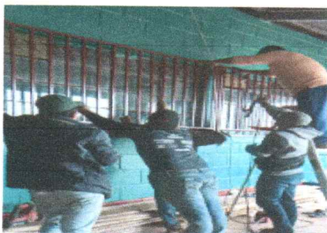
Foto 5: En proceso de fabricación e instalación de balcones de hierro en ventana
