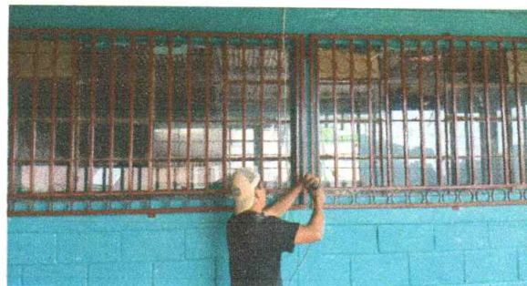
Foto 6: en proceso de Sustitución de vidrios
