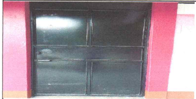
Foto 4: Foto 4: Mantenimiento de estructura de puertas de metal
