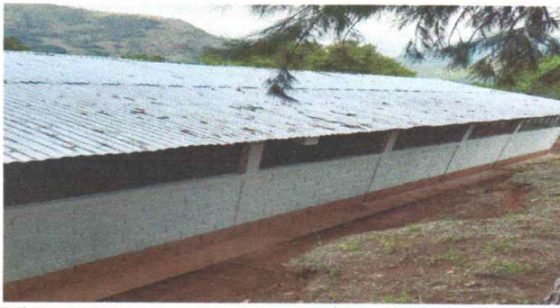
Foto1: Mantenimiento a cubierta de Lámina con pintura
