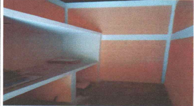
Foto 2: Mejoramiento de mesa de concreto.
