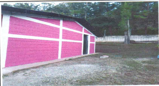
Foto7: Pintura en muros exteriores e interiores
