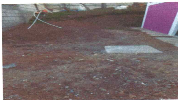
Foto8: Reparación de tubería para drenaje.
