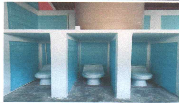
Foto 3: Sustitución de inodoros y puertas
