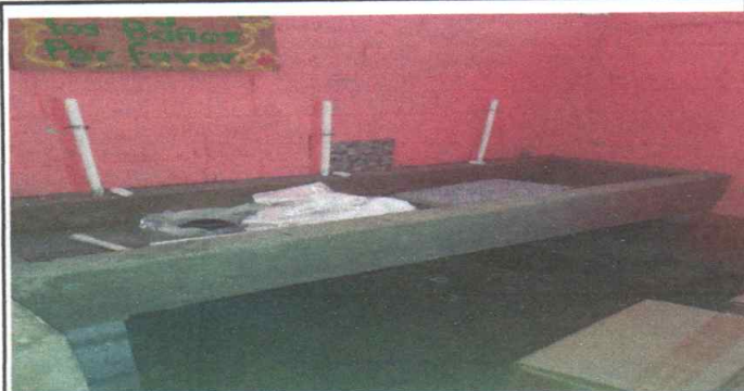
Foto9: Mejoramiento de lavamanos de concreto
