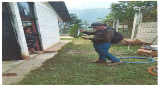
Foto 4: Mantenimiento de estructura de puertas de metal
