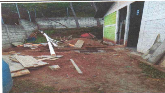
Foto8: Reparación de tubería para drenaje.
