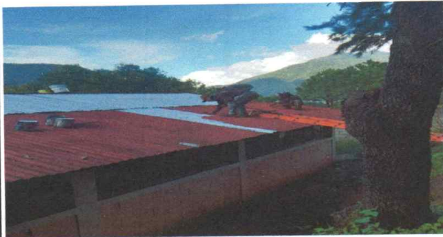
Foto No. 1: Mantenimiento a cubierta de Lámina con pintura
