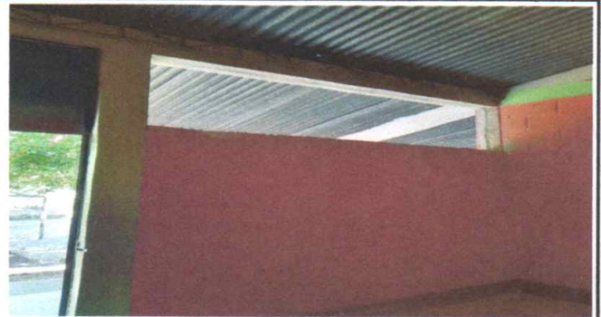
Foto 6: Mejoramiento de ventanas y balcones
