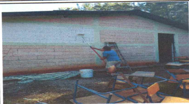
Foto7: Pintura en muros exteriores e interiores
