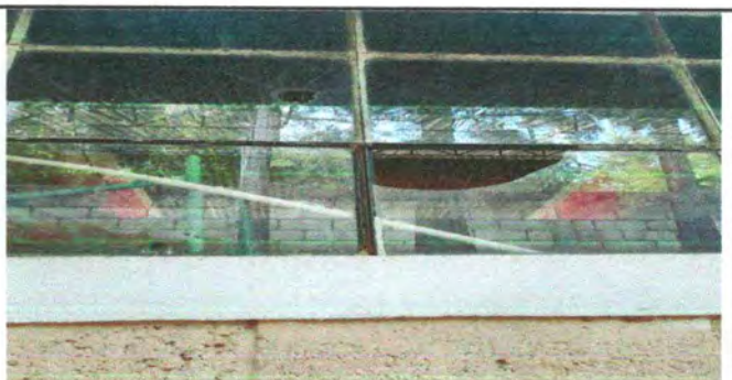
Foto 6: Mejoramiento de ventanas y balcones
