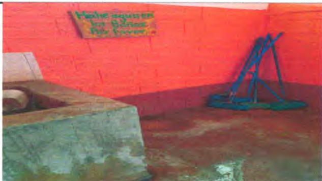
Foto9: Mejoramiento de lavamanos de concreto
