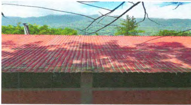
Foto1: Mantenimiento a cubierta de Lámina con pintura
