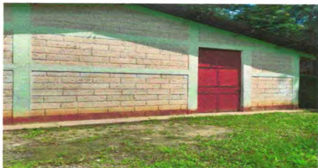
Foto7: Pintura en muros exteriores e interiores
