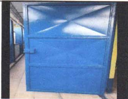
Foto 17: PUERTA DE METAL SUSTITUCION DE CHAPAS
