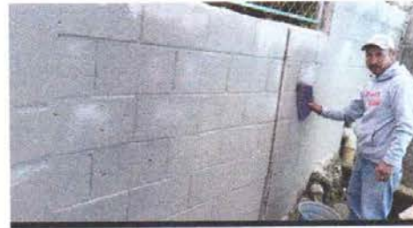
Foto 10: PINTURA EN MUROS EXTERIORES E INTERIORES
