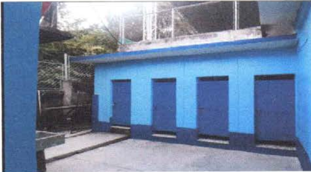
Foto 7: PINTURA EN MUROS EXTERIORES E INTERIORES
