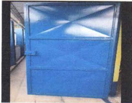
Foto 15: PUERTA DE METAL SUSTITUCION DE CHAPAS
