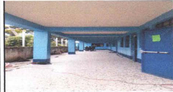
Foto 8: PINTURA EN MUROS EXTERIORES E INTERIORES
