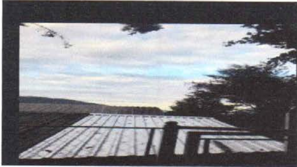
Foto 13: ESTRUCTURA DE TECHO
