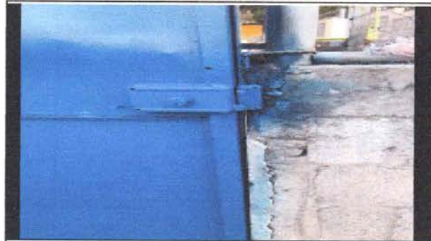
Foto 16: PUERTA DE METAL SUSTITUCION DE CHAPAS
