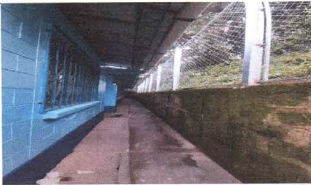
Foto 9: PINTURA EN MUROS EXTERIORES E INTERIORES
