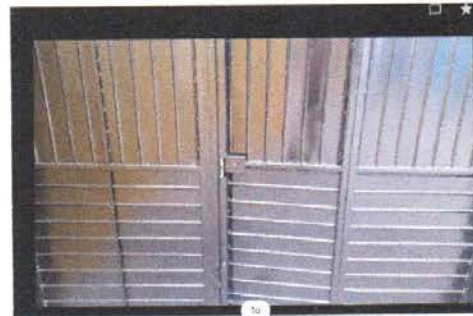
Foto 12: MANTENIMIENTO A PORTONES
