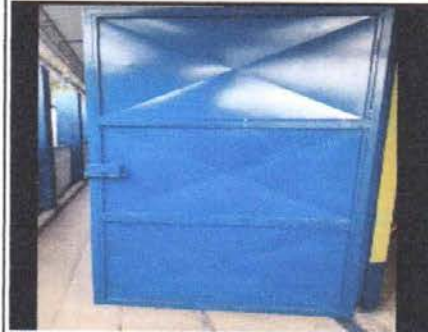
Foto 14: PUERTA DE METAL SUSTITUCION DE CHAPAS
