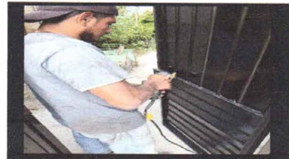
Foto 12: MANTENIMIENTO A PORTONES
