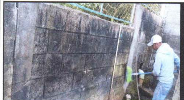
Foto 10: PINTURA EN MUROS EXTERIORES E INTERIORES
