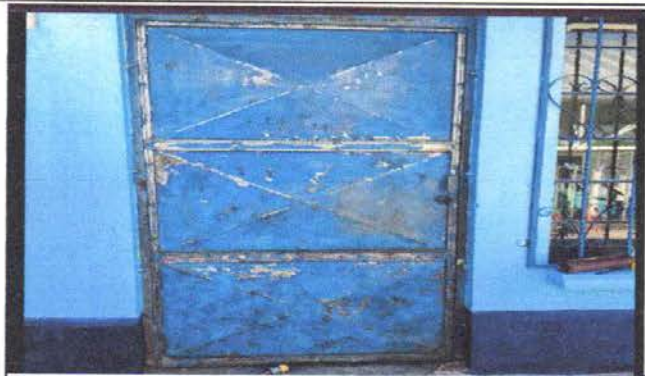
Foto 14: PUERTA DE METAL SUSTITUCION DE CHAPAS
