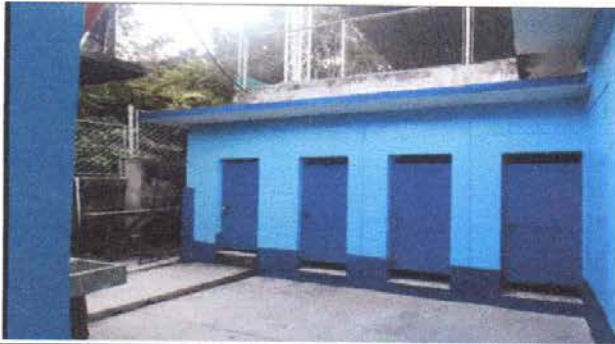
Foto 7: PINTURA EN MUROS EXTERIORES E INTERIORES
