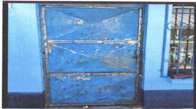
Foto 16: PUERTA DE METAL SUSTITUCION DE CHAPAS
