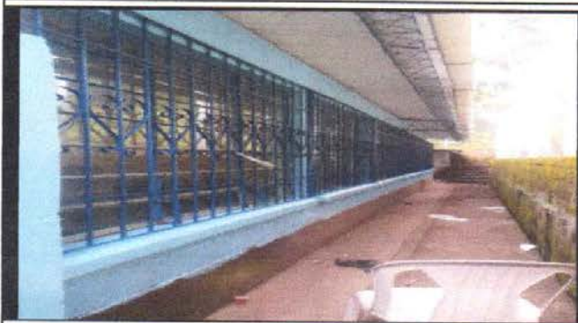
Foto 9: PINTURA EN MUROS EXTERIORES E INTERIORES
