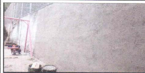
Foto 18: REPARACION DE REPELLO Y CERNIDO EN PAREDES
