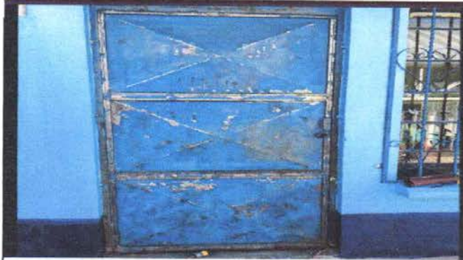
Foto 17: PUERTA DE METAL SUSTITUCION DE CHAPAS
