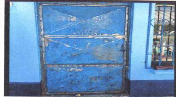
Foto 15: PUERTA DE METAL SUSTITUCION DE CHAPAS
