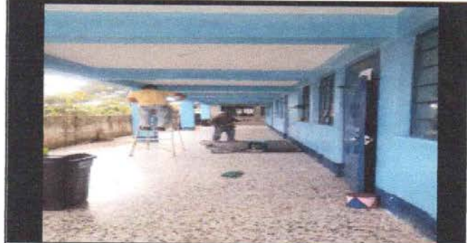
Foto 8: PINTURA EN MUROS EXTERIORES E INTERIORES
