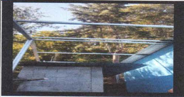
Foto 13: ESTRUCTURA DE TECHO
