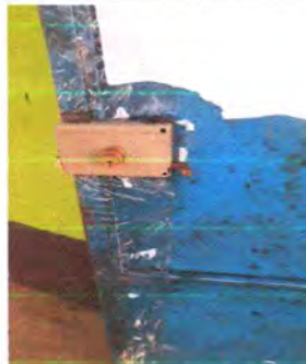
Foto 14: PUERTAS DE METAL, SUSTITUCION DE CHAPAS
