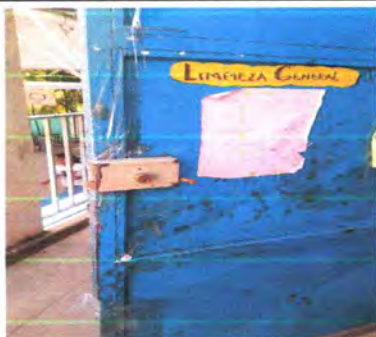
Foto 15: PUERTAS DE METAL, SUSTITUCION DE CHAPAS
