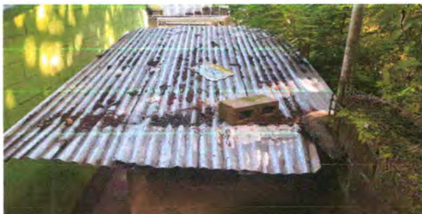
Foto 13: ESTRUCTURA DE TECHO
