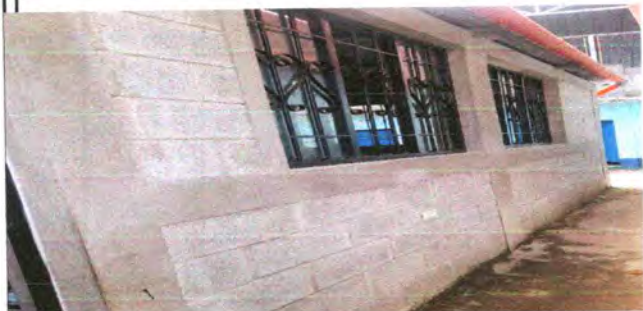
Foto 11: PINTURA EN MUROS EXTERIORES E INTERIORES
