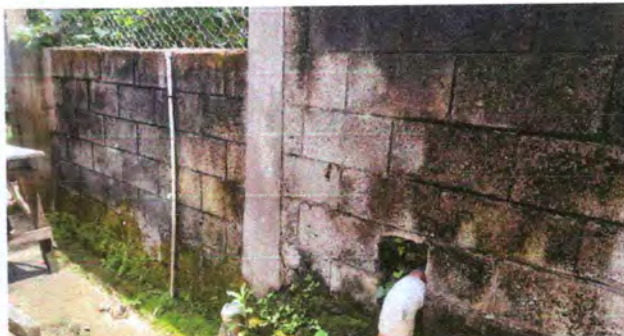
Foto 10: PINTURA EN MUROS EXTERIORES E INTERIORES
