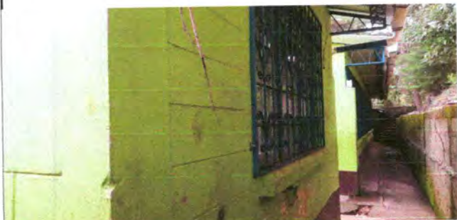
Foto 9: PINTURA EN MUROS EXTERIORES E INTERIORES
