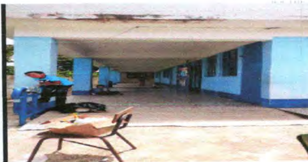
Foto 8: PINTURA EN MUROS EXTERIORES E INTERIORES
