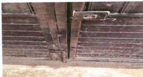
Foto 12: MANTENIMIENTO A PORTONES
