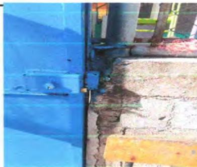
Foto 16: PUERTAS DE METAL, SUSTITUCION DE CHAPAS
