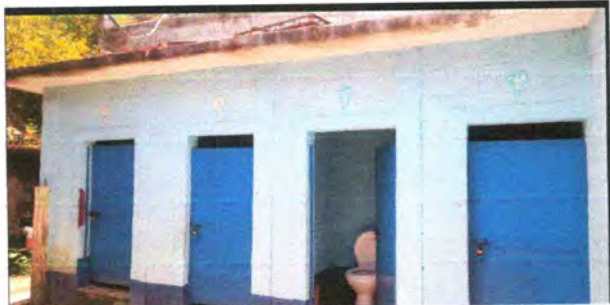
Foto 7: PINTURA EN MUROS EXTERIORES E INTERIORES
