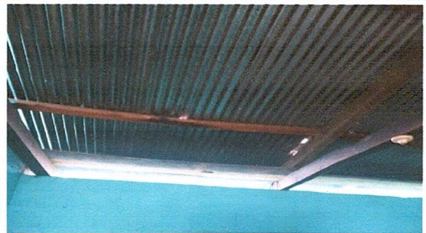
En la cocina el techo y costaneras de madera estan en mal estado por las fuertes lluvias de la tormenta pilar, puertas y ventanas de madera en mal estado, no tiene piso, pila en mal estado, acumulacion de agua y lodo por
