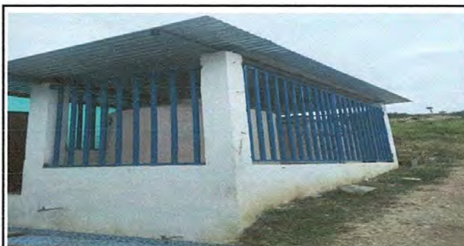
Foto 4: sustitución de malla multichorros
