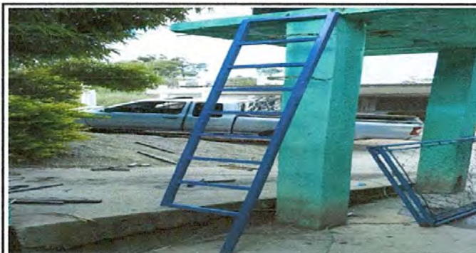
Foto 6: sustitución de 2 escalera rotoplas
