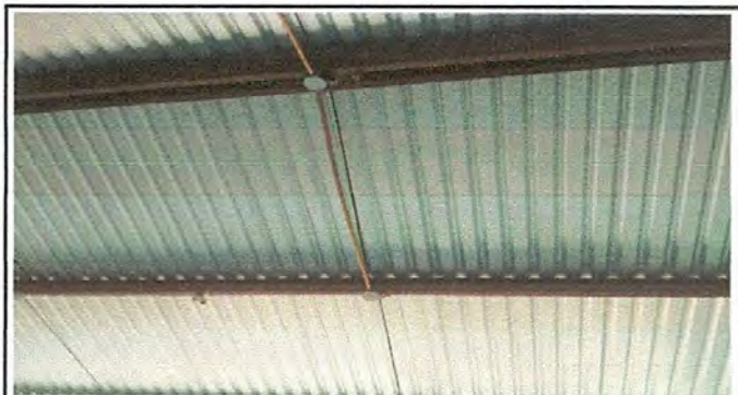
Foto 3: sustitución de lamina
