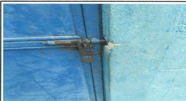
Foto 5: mantenimiento de puertas
