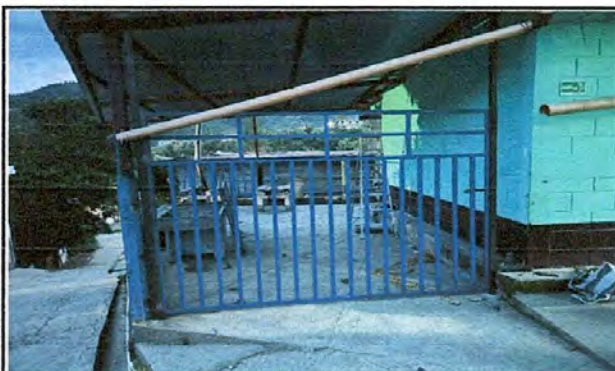
Foto 3: sustitución de porton
