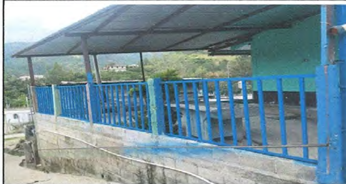
Foto 2: sustitución de cerco de maya
