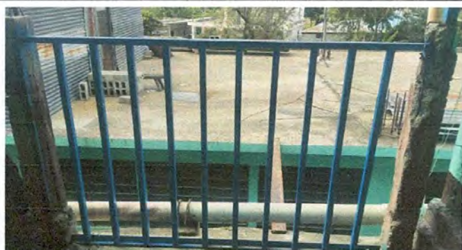
Foto1: sustitución de baranda de cocina
