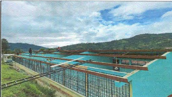
Foto 4: Sustitución de lamina
