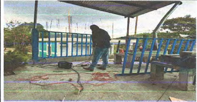
Foto 2: sustitución de cerco de maya
