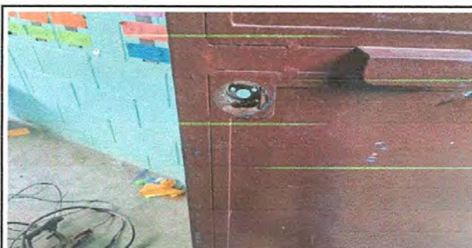
Foto 6: sustitución de la chapa
