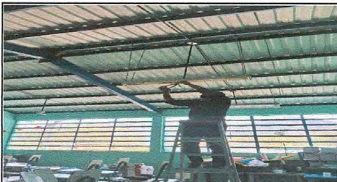
Foto 3: cambio de instalación electrica
