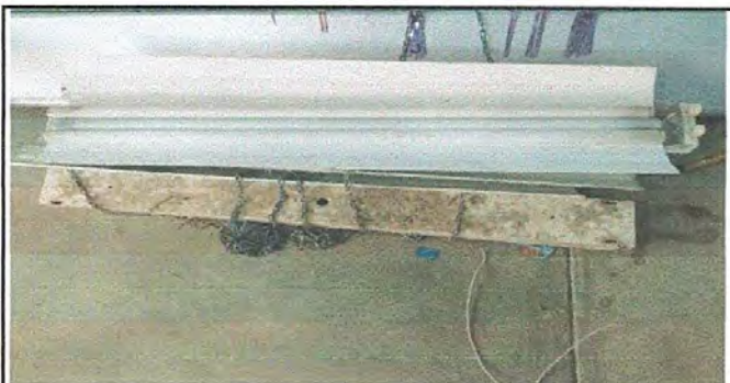
Foto 5: sustitución de base de bombillas
