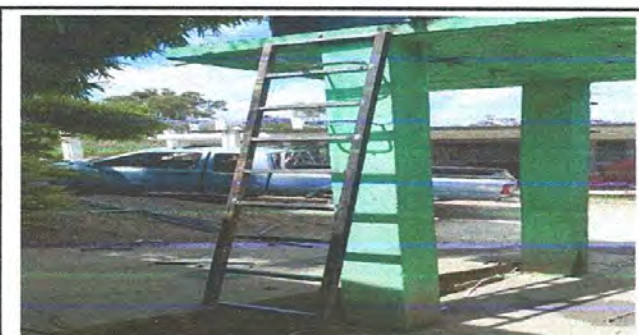
Foto 6: sustitución de 2 escalera rotoplas
