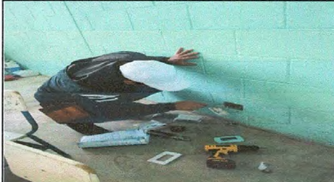
Foto 2: sustitucion de tomacorriente doble
