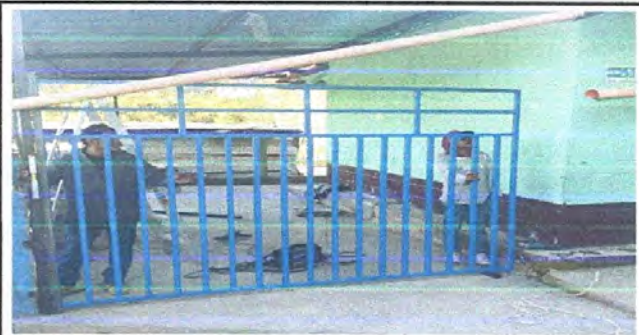
Foto 4: sustitución de porton
