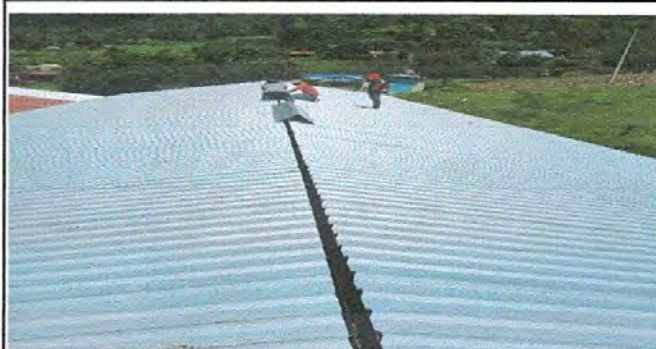
Foto 2: sustitución de capote
