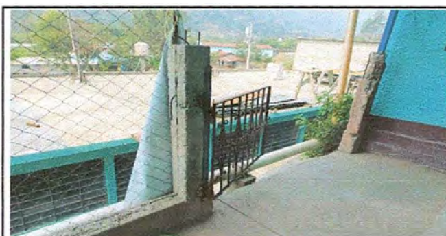
foto 12. sustitucion de baranda
