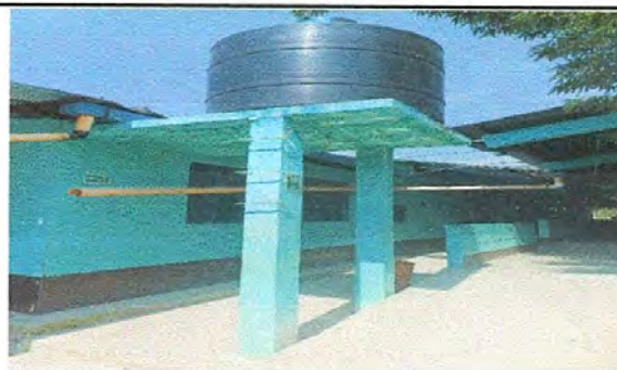
foto 6. colocación de escalera para 2 rotoplas
