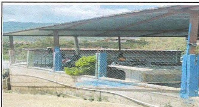
foto 9. sustitución de cerco de maya
