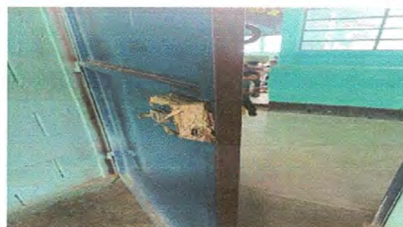
foto 4. sustitucion de Chapas
