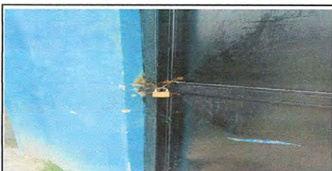
foto 11. mantenimiento a 7 puertas de sanitarios
