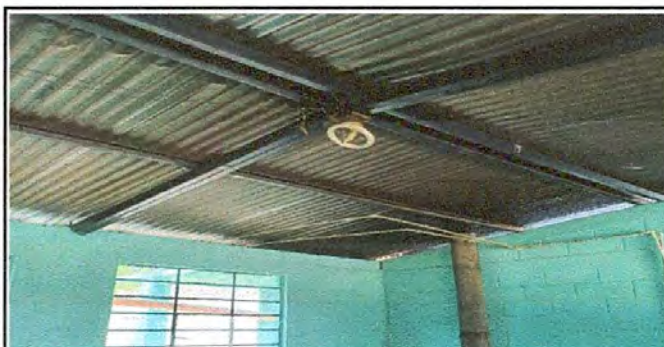
foto 10. sustitucion de focos a 12 aulas
