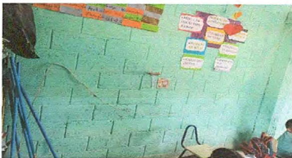
foto 5. sustitucion de instalación electrica
