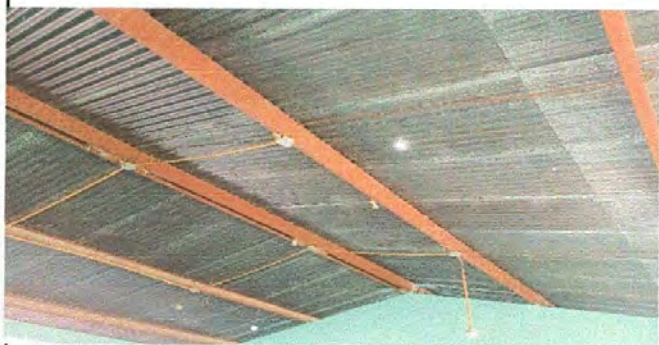
foto 1. cambio de techo, laminas
