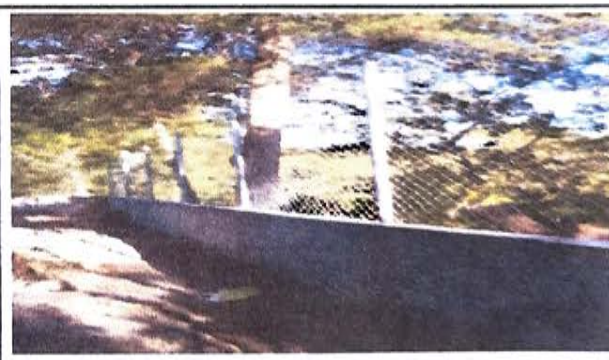
FOTO 6: MEJORAMIENTO DE CIRCULACIÓN CON BLOCK Y MALLA
