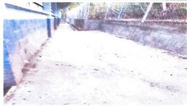
FOTO 3: MEJORAMIENTO DE CUNETAS PARA DESFOGE DE AGUAS PLUVIALES
