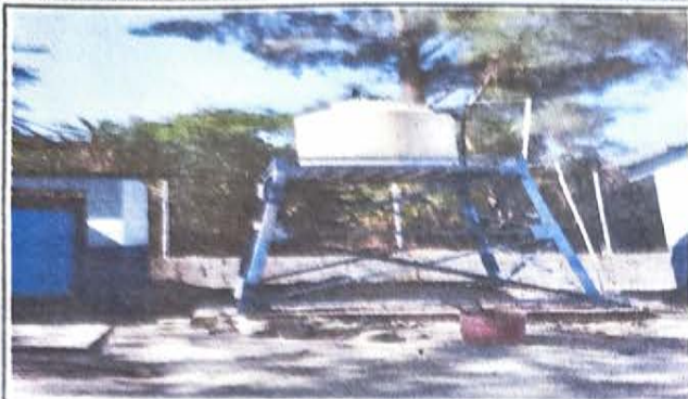
FOTO 1: SUSTITUCION DE ROTOPLAS
