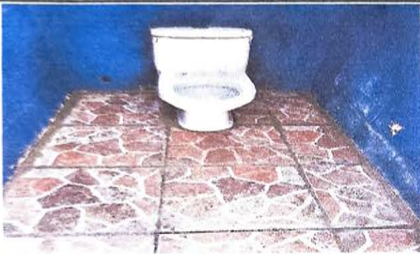
FOTO 3: SUSTITUCIÓN DE SANITARIOS
