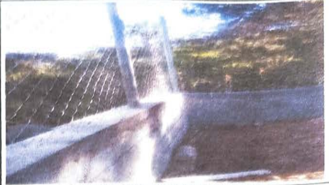
FOTO 2: REPARACION DE MURO PERIMETRAL DE BLOCK
