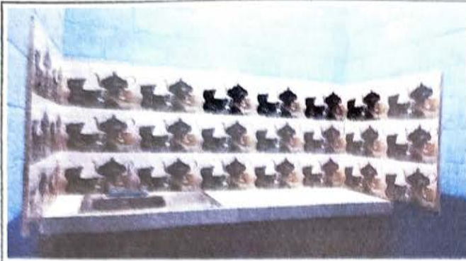
FOTO 1: COLOCACION DE AZULEJO EN PAREDES DE LAVATRASTOS
