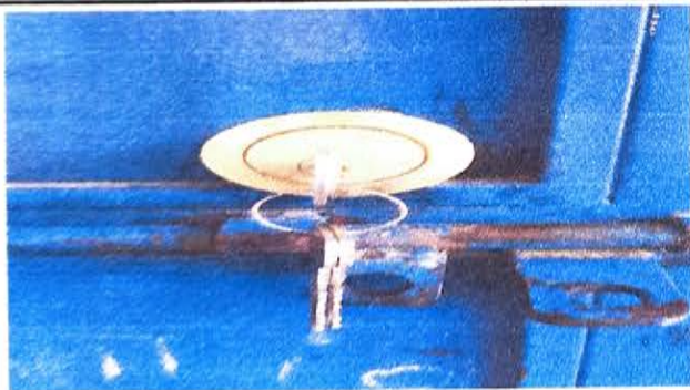
FOTO 6: CAMBIO DE CHAPAS
