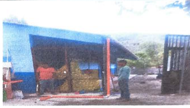
FOTO 4: MEJORAMIENTO DE BAJAS DE AGUA PLUVIAL
