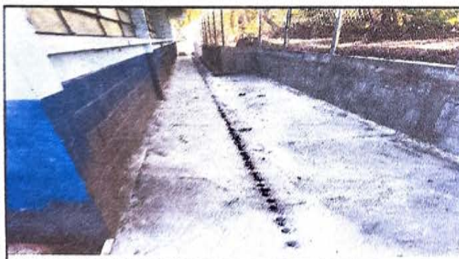
FOTO 5: MEJORAMIENTO DE CUNETA
