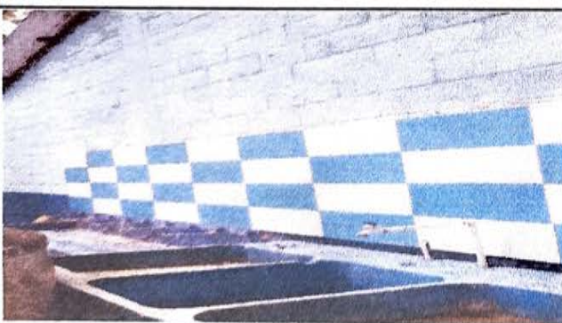
FOTO 5: SUSTITUCION DE AZULEJO EN LAVAMANOS
