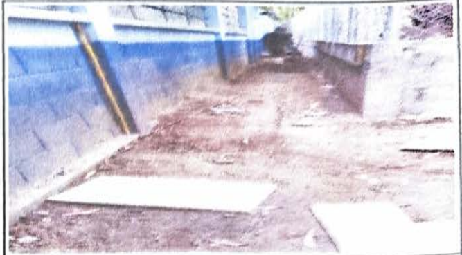
FOTO2: MANTENIMIENTO A CUNETAS
