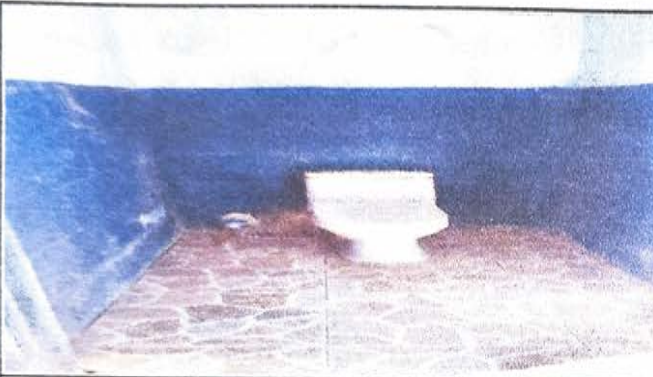
FOTO 3: SUSTITUCIÓN DE SANITARIOS
