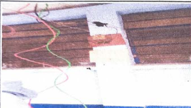
FOTO3: REPARACION DE CABLEADO ELECTRICO
