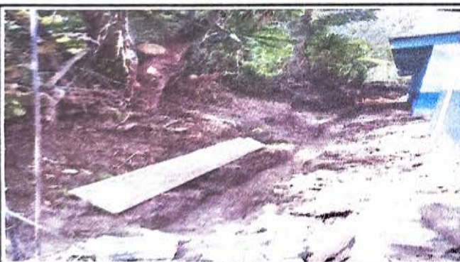
FOTO 5: MANTENIMIENTO DE CUNETA
