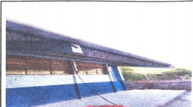
FOTO 4: MEJORAMIENTO DE AGUA PLUVIAL Y CANALES DE PVC
