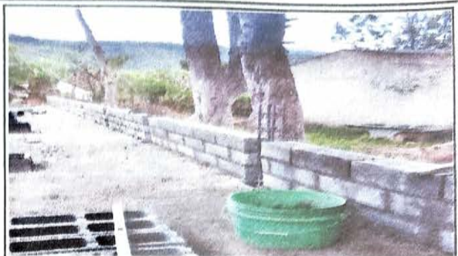
FOTO 2: REPARACION DE MURO PERIMETRAL DE BLOCK
