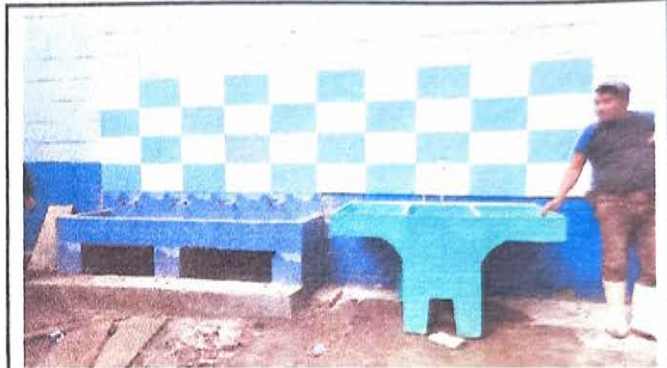
FOTO 4: SUSTITUCION DE PILA
