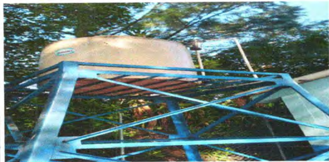
FOTO 1: SUSTITUCION DE ROTOPLAS
