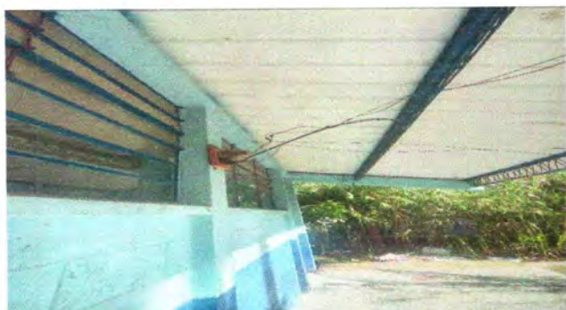
FOTO3: REPARACION DE CABLEADO ELECTRICO
