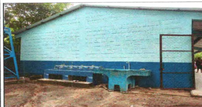
FOTO 5: SUSTITUCION DE PORTON
