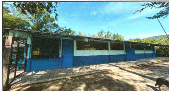
FOTO4: CAMBIO DE BALCONES
