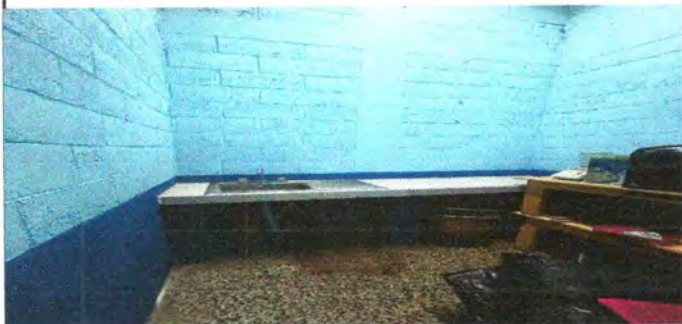
FOTO 1: COLOCACION DE AZULEJO EN PAREDES DE LAVATRASTOS
