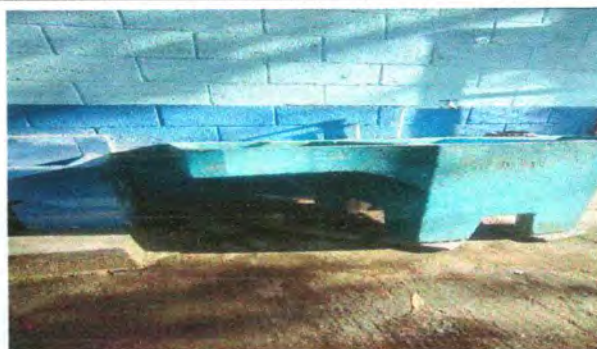
FOTO 4: SUSTITUCION DE PILA
