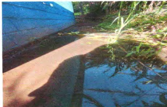
FOTO2: MANTENIMIENTO A CUNETAS
