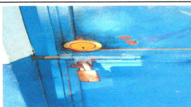
FOTO 6: MANTENIMIENTO A PUERTAS Y CAMBI DE CHAPAS
