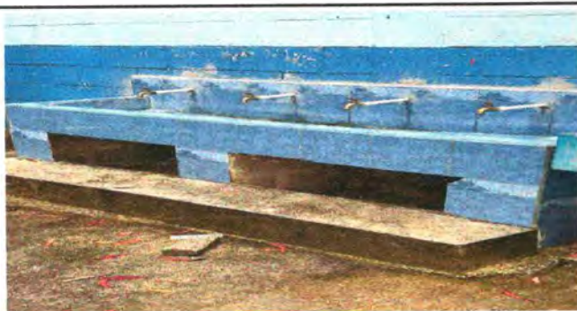
FOTO 5: SUSTITUCION DE AZULEJO EN LAVAMANOS
