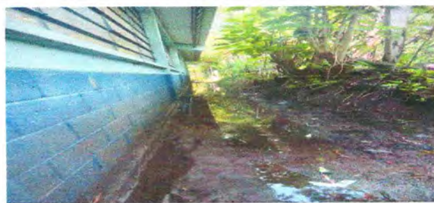
FOTO6: MEJORAMIENTO DE CUNETETA
