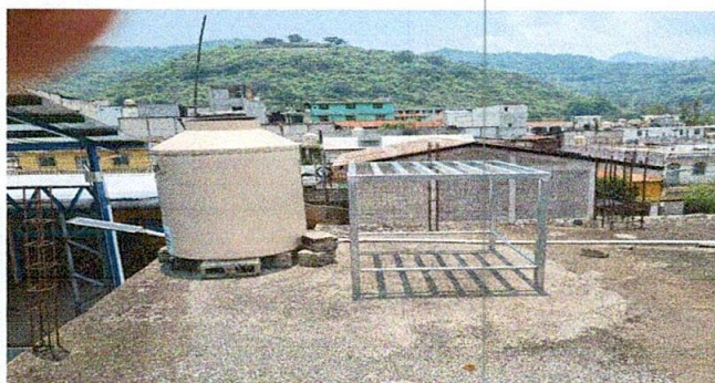
Foto 3: Mejoramiento de bases de tinacos, estan deteriorando la terraza
