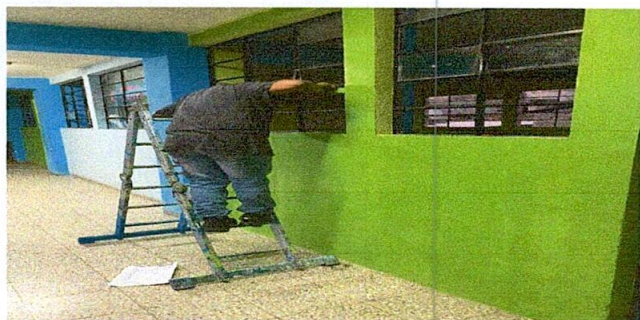
Foto 5: Pintura en muro exterior e interior, 1,400 m2, por deterioro de más de 5 años.
