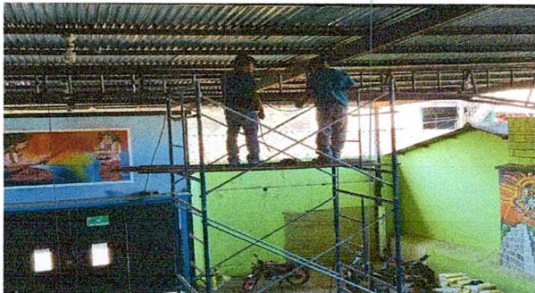
Foto 1: Lijado y pintado de estructura metálica techo por deterioro de pintura y presenta óxido.
