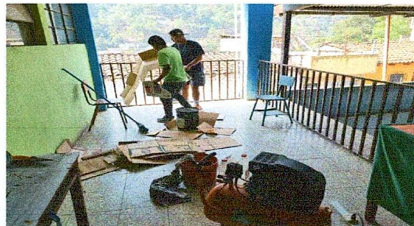
Foto 2: Lijado y pintado de baranda de rampa y segundo nivel, por deterioro de pintura.
