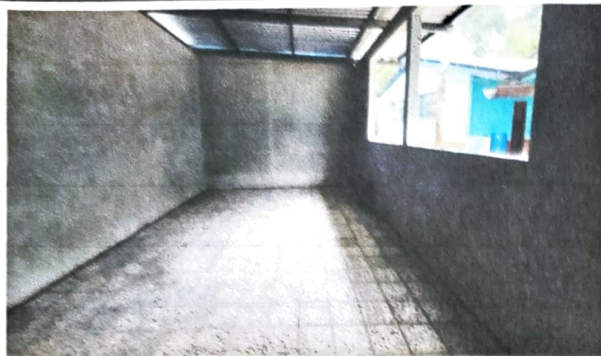
Foto1: SUSTITUCIÓN DE PISO
