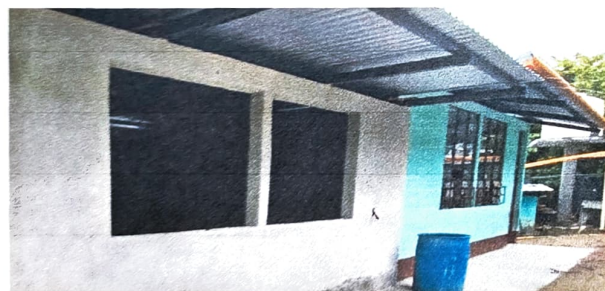
Foto 5: ESTRUCTURA DE TECHO
