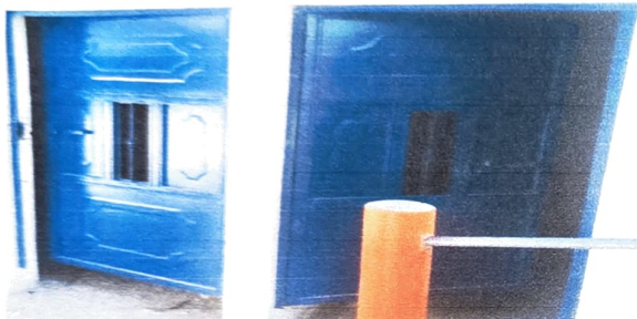
Foto 3: PUERTAS DE MODULO DE BAÑOS
