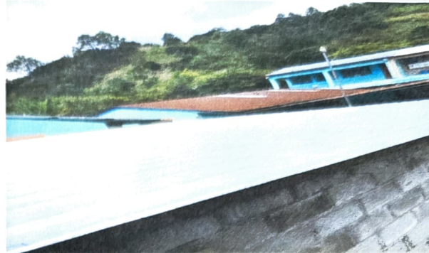
Foto 2: SUSTITUCIÓN DE TECHO DE LÁMINA TROQUELADA
