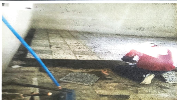
Foto 3: SUSTITUCIÓN DE PISO
