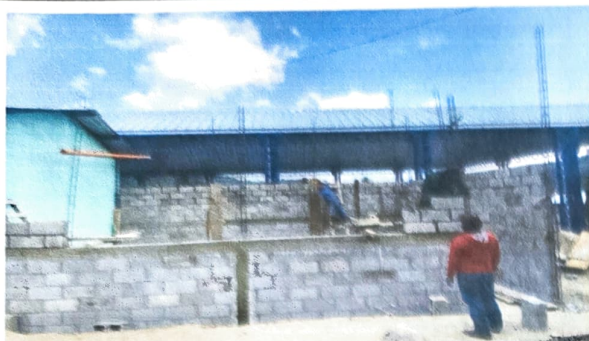
Foto1: SEGUIMIENTO DE LEVANTADO DE PARED
