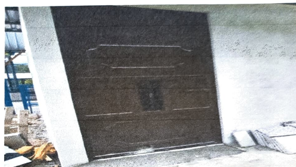
Foto 4: COLOCACIÓN DE PUERTA DE METAL
