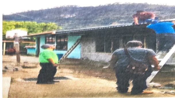
Foto 2: COLOCACIÓN DE TECHO DE LÁMINA TROQUELADA
