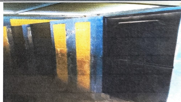
Foto 6: colocación de puertas módulo de baños
