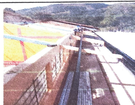
Foto 6: Cambio de techo
