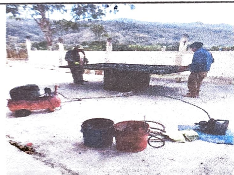
Foto 3: Sustitución de valcones de ventanas
