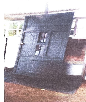
Foto 4: Sustitución de puertas de metal
