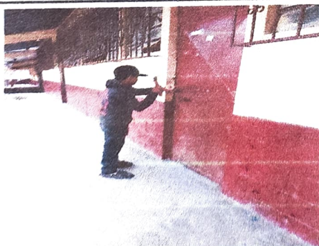
Foto 5: Sustitución de chapas
