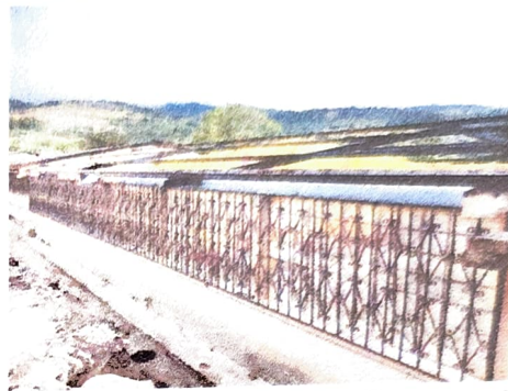
Foto 2: Mantenimiento a estructura de metal portante de techo
