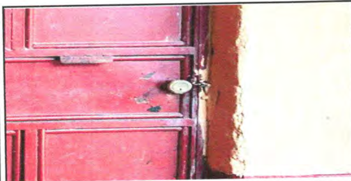
FOTO 5: SUSTITUCIÓN DE CHAPAS
