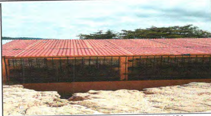
FOTO 1: SUSTITUCIÓN DE LAMINA POR LAMINA TROQUELADA
