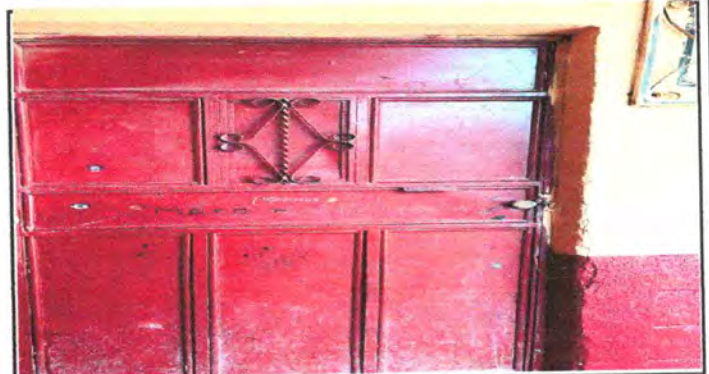
FOTO 4: SUSTITUCIÓN DE PUERTAS DE METAL
