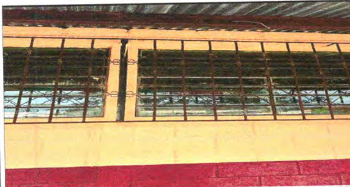
FOTO 3: SUSTITUCIÓN DE BALCONES DE VENTANAS
