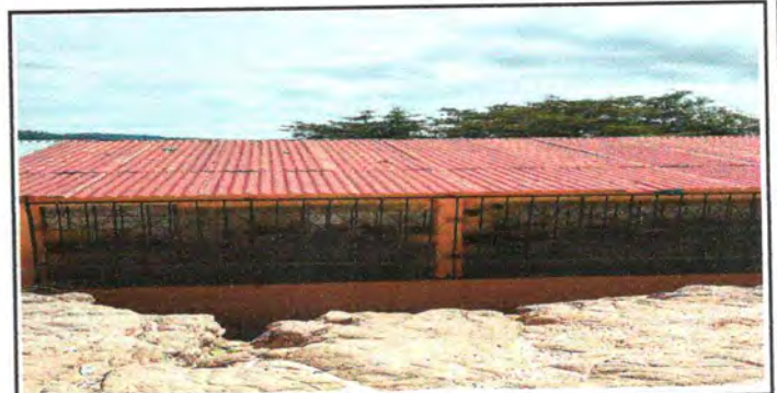
foto 6: cambio de techo
