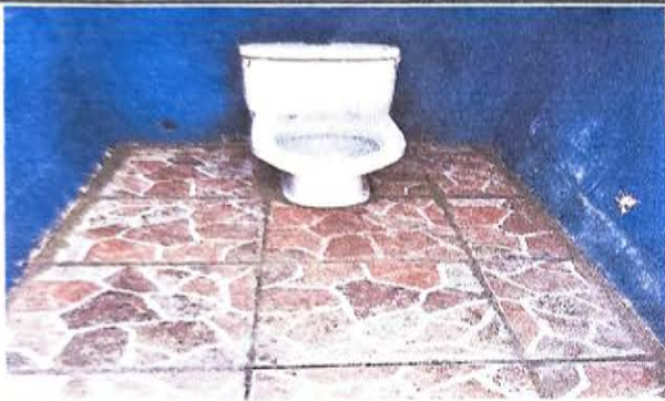
FOTO 3: SUSTITUCIÓN DE SANITARIOS
