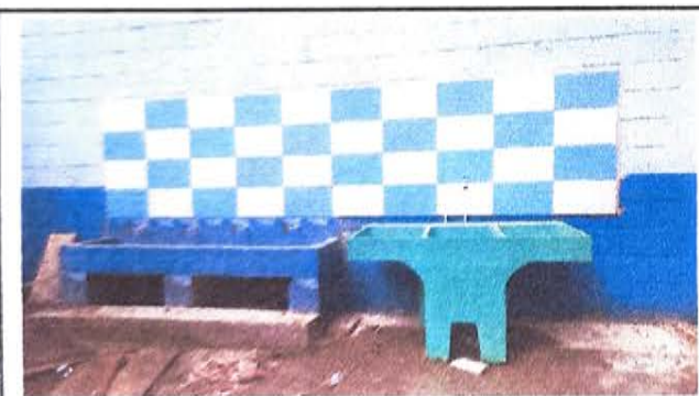
FOTO 5: SUSTITUCION DE AZULEJO EN LAVAMANOS
