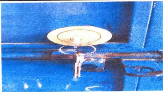
FOTO 6: CAMBIO DE CHAPAS
