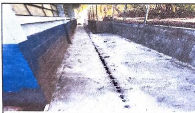
FOTO 5: MEJORAMIENTO DE CUNETA
