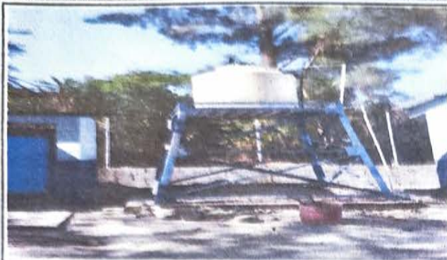
FOTO 1: SUSTITUCION DE ROTOPLAS
