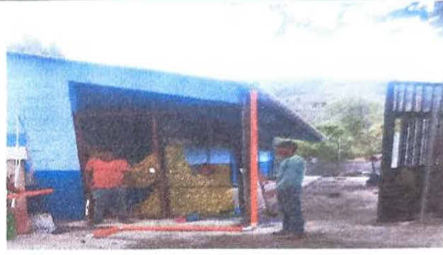
FOTO 4: MEJORAMIENTO DE BAJAS DE AGUA PLUVIAL
