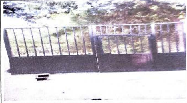
FOTO 4: SUSTITUCIÓN DE PORTÓN
