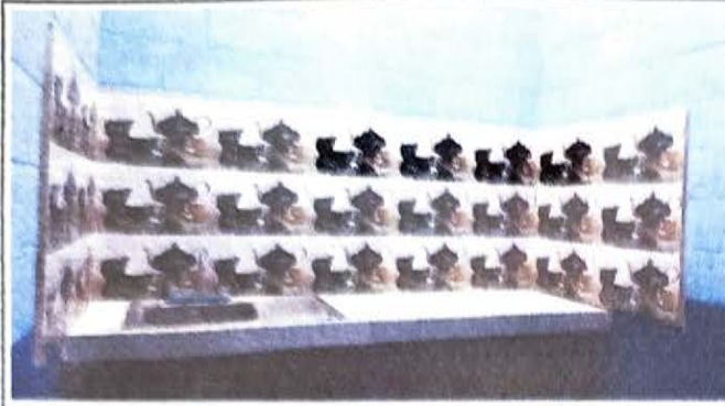
FOTO 1: COLOCACION DE AZULEJO EN PAREDES DE LAVATRASTOS
