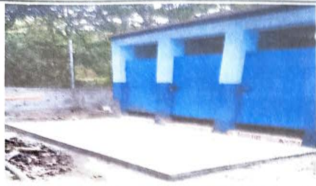
FOTO1: COLOCACION DE PISO ANTIDESLIZANTE EN BAÑOS
