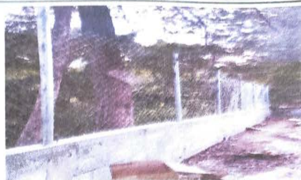
FOTO2: MEJORAMIENTO EN MURO PERIMETRAL DE BLOCK Y MALLA
