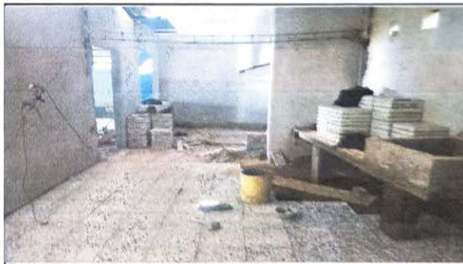
Foto 6: Repello de las paredes de la cocina.
