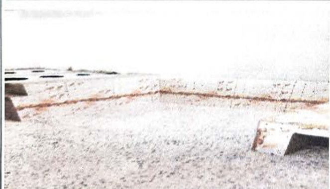
Foto 5: Piso de granito colocado en el área de estufas.
