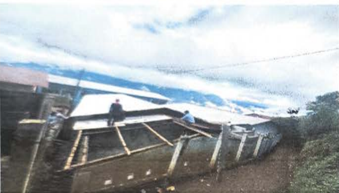
Foto 3: Sustitución de techo y estructura de madera por metal.
