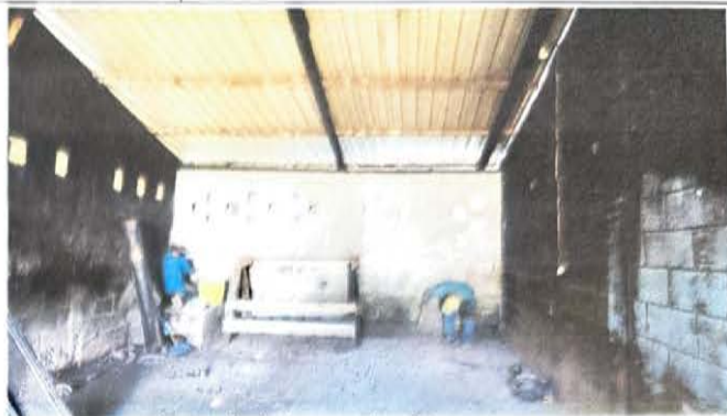
Foto 2: Inicio del repello de las paredes de la cocina.
