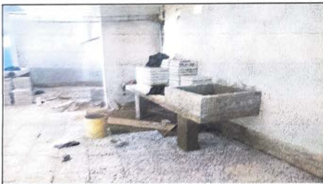
Foto 5: Piso de granito ya colocado en la mitad de la cocina.
