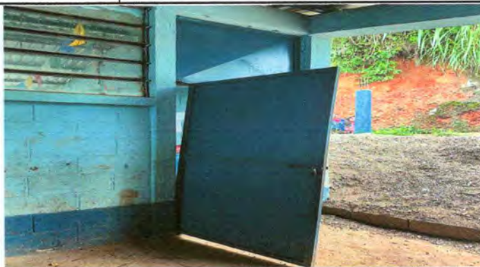
Foto 2: Esta puerta como las otras dos necesita cambiarse, pues están sujetadas con tornillos, causando inseguridad para los estudiantes, pues a cada rato se cae. la chapa ya no sirve y tienen demasiado óxido.
