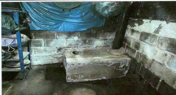
Foto 2: Las estufas artesanales se encuentran inservibles y es necesario hacer algunos arreglos para buscarle salida al humo.
