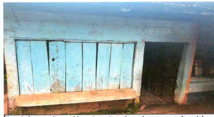
Foto 6: Se necesita cambiar esta ventana de madera, por una de metal. Pues se dificulta el abrirla y no es nada segura.
