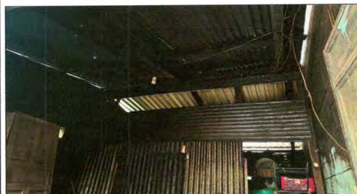
Foto 3: Las láminas están sujetadas en madera, nesecita sustituirse por costaneras, para darle mayor seguridad, esto en el techo de la cocina.
