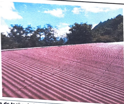
Foto 5: Pintura de techo de lamina culminado
