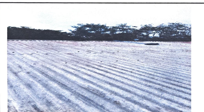
Foto 5: Lijada de techo de lamina
