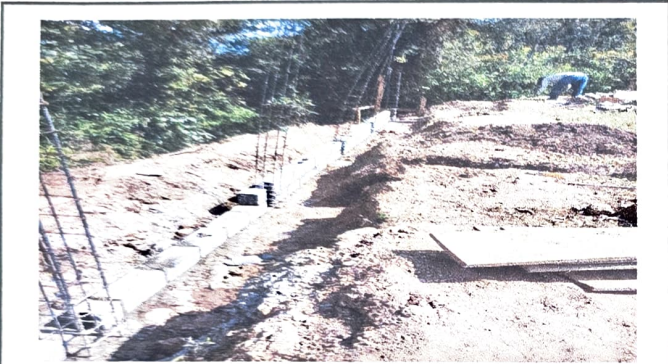
Foto 3: Muro de contención en proceso de construcción
