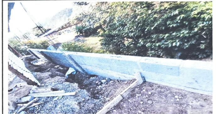
Foto 4: Trabajando muro de contención
