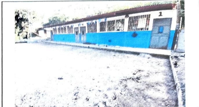
Foto 2: torta de cemento en proceso
