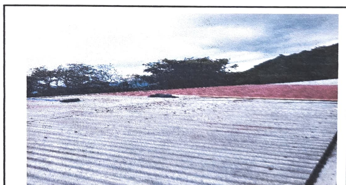
Foto 6: pintando de techo de lamina
