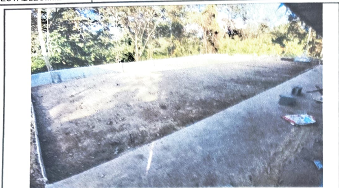
Foto 1: Reparación de piso torta de cemento
