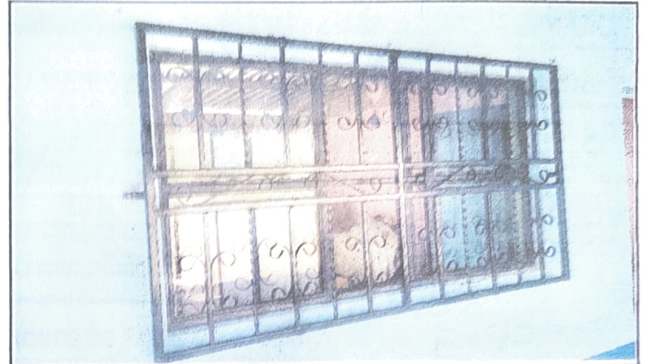
Foto 2: SUSTITUCION DE VENTANAS
