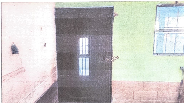
Foto 5: SUSTITUCION DE PUERTAS
