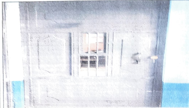
Foto1: SUSTITUCION DE PUERTAS
