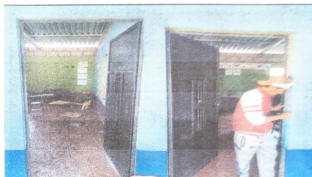
Foto 4: SUSTITUCION DE PUERTAS
