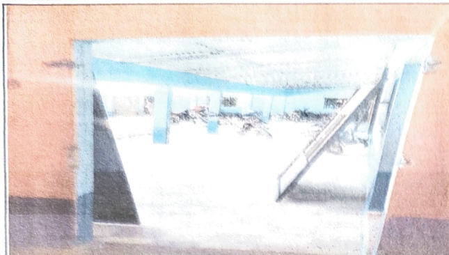
Foto 1: SUSTITUCION DE PUERTAS
