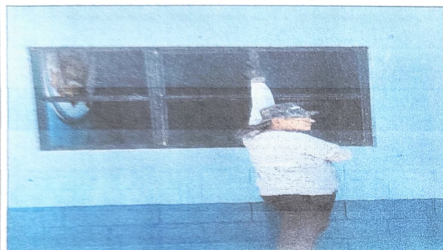
Foto 3: SUSTITUCION DE VENTANAS
