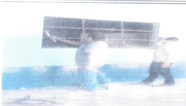
Foto 2: SUSTITUCION DE VENTANAS
