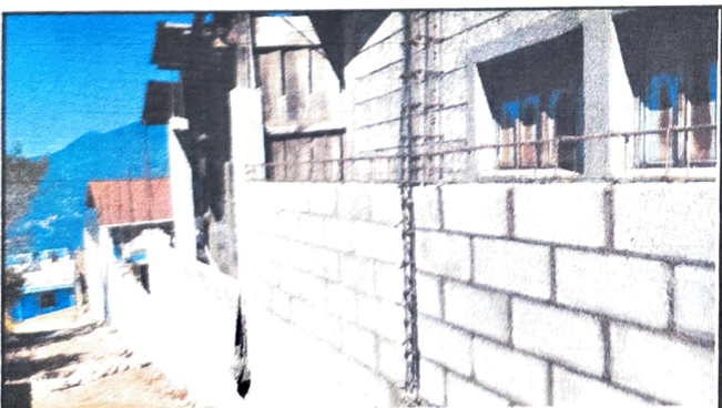
Foto 5: Muro reconstruido (Terminado)
