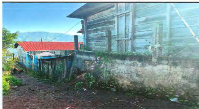
Foto 4: Toda esta parte abarcará la construcción del muro.
