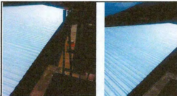
Foto 1: Sustitución de lámina de zin por lámina troquelada.
