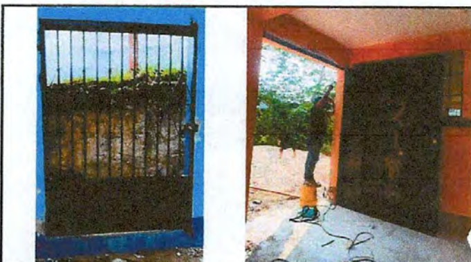
Foto 4: Sustitución de portón.
