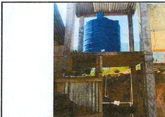
Foto 2: Sustitución de depósito de almacenamiento de agua.
