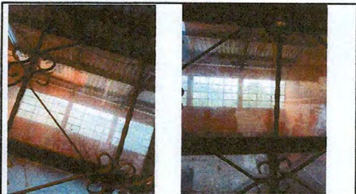
Foto 3: Sustitución de vidrios.
