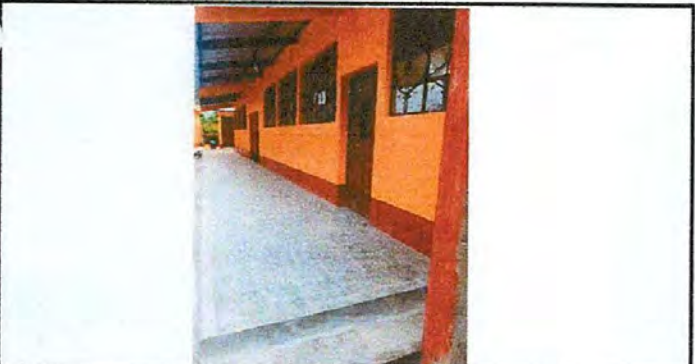
Foto 5: Sustitución de piso.
