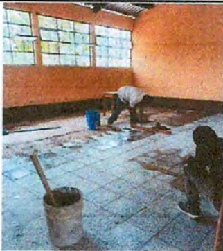
Foto 5: Sustitución de piso.
