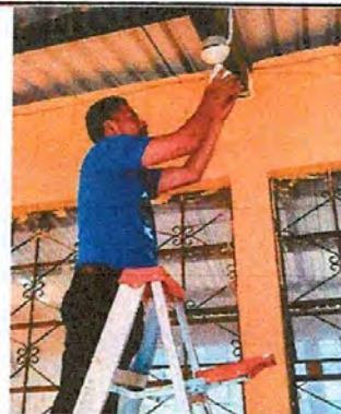
Foto 8: Sustitución de lámparas.
