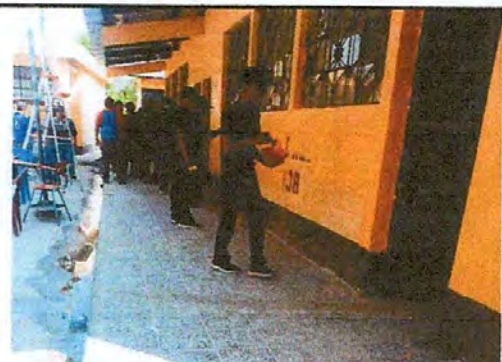
Foto 6: Aplicación de pintura.
