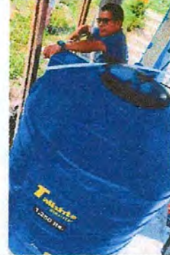
Foto 2: Sustitución de depósito de almacenamiento de agua.
