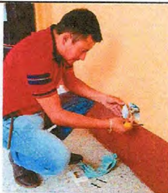
Foto 7: Sustitución de tomacorrientes.
