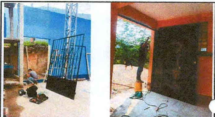
Foto 4: Sustitución de portón.
