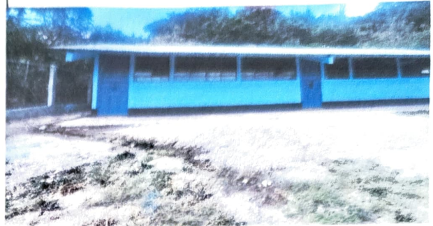
Foto 2: Puertas existentes ya pintadas.
