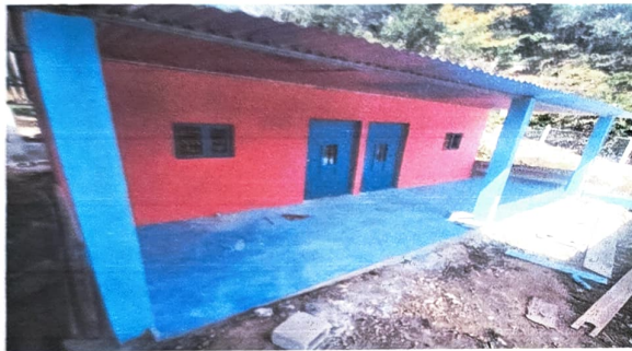
Foto 3: puertas nuevas instaladas y piso.
