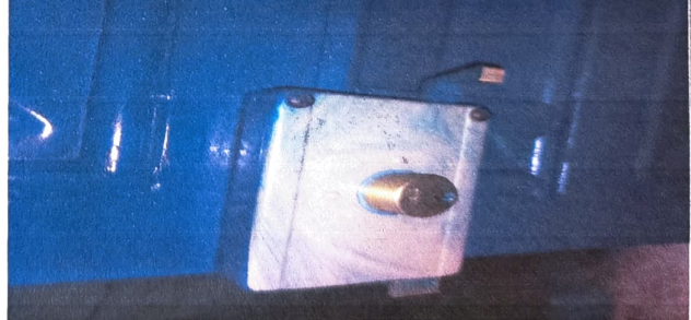
Foto 6: Chapas cambiadas e instaladas.
