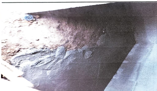
Foto 3: Tirando losa para el piso de la bodega escolar.
