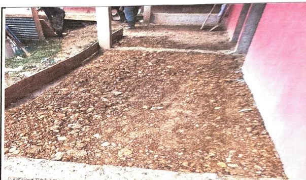
Foto 4: corredor listo para tirar cemento.
