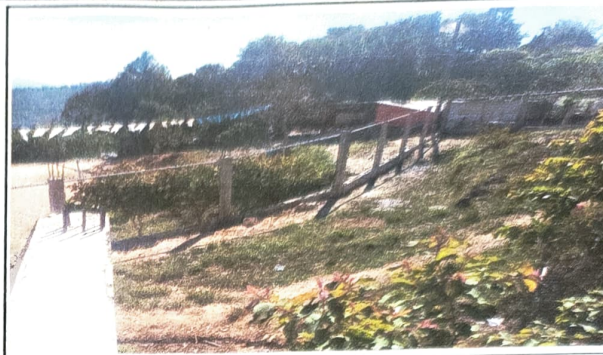
Foto 2: Columnas ya con tubos.
