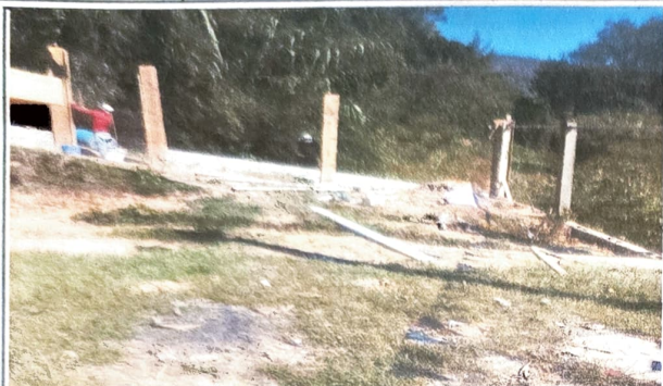
Foto1: Padres armando tablas para las columnas de la Circulacion.
