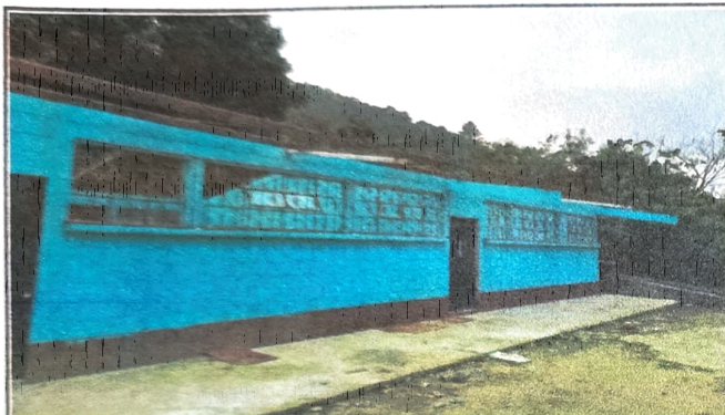
Foto 3: CAMBIO DE COSTANERAS
