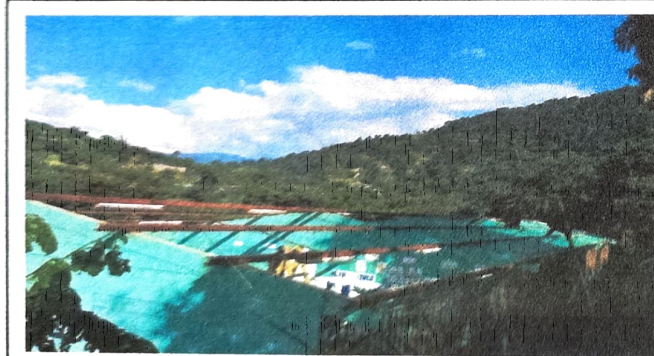
Foto 5: CAMBIO DE PINTURA
