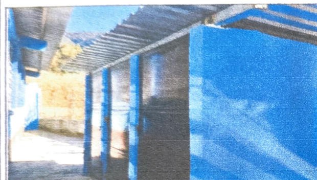
Foto 3: Sustitución de láminas de los sanitarios
