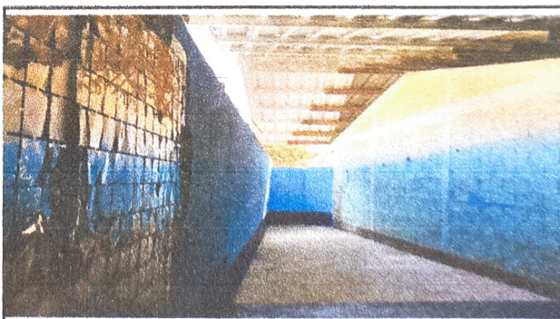
Foto 6: Enlaminado y pintura del establecimiento.
