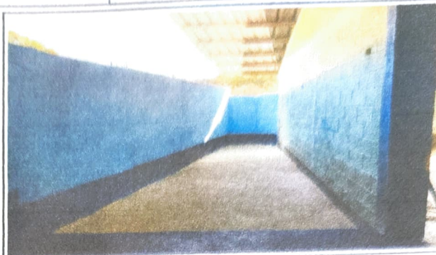
Foto 2: Terminación del muro perimetral y pintado
