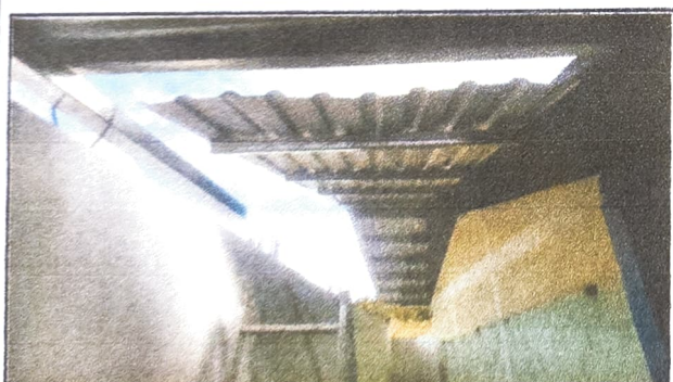
Foto 5: Sustitución de lámina del corredor
