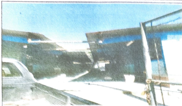
Foto 1: Sustitución de lámina y estructura de comedor y colocación de canal PVC
