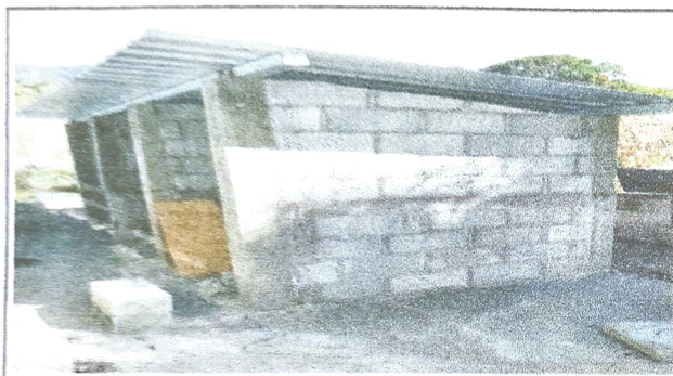
Foto 3: Estructura de los sanitarios
