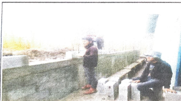
Foto 5: Sustitución de muro perimetral
